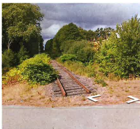
Figur 10. Spår omf avskuret av väg E45 i höjd med cirkulationsplats E45/Dalslandsgatan, riktning västerut
