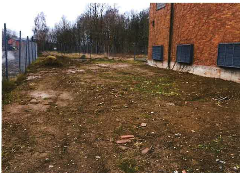
Figur 7. Omformarstationen från sidan
