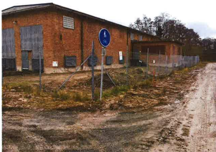
Figur 6. Omformarstationen, vy mot öster
