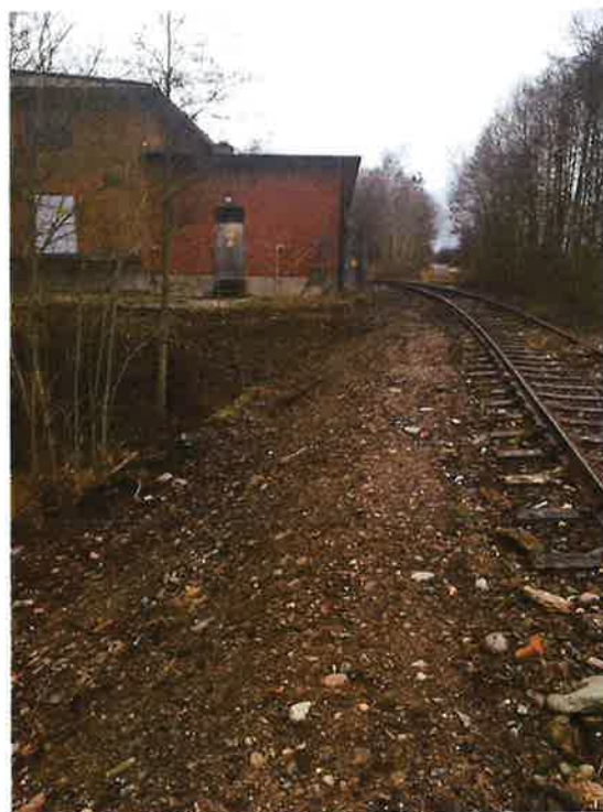
Figur 7. Spår omf i riktning mot väster. Omformastation till vänster i bild.
