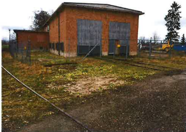
Figur 4. Omformarstationen, vy mot öster
