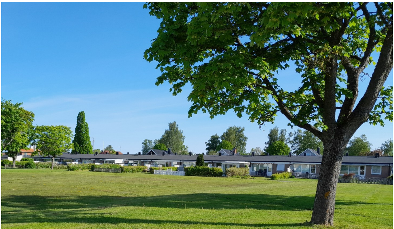
Södra fasaden på Korpen 1
