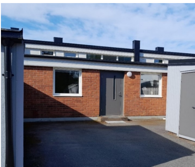
Norra fasaden med tegel samt östra fasaden med fibercementskivor.
