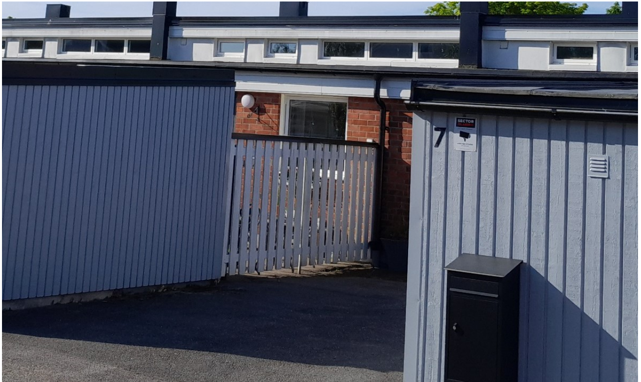
Plank mellan huvudbyggnad och komplementbyggnad
