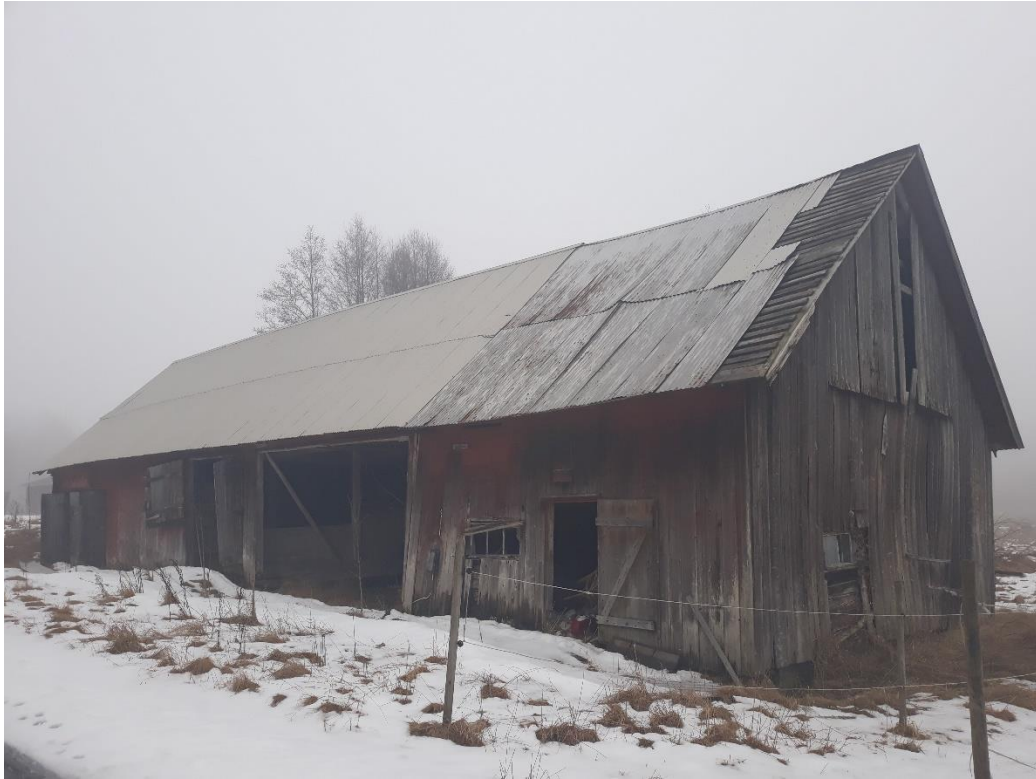
Byggnad vid område 8 som omfattas av föreläggandet.
