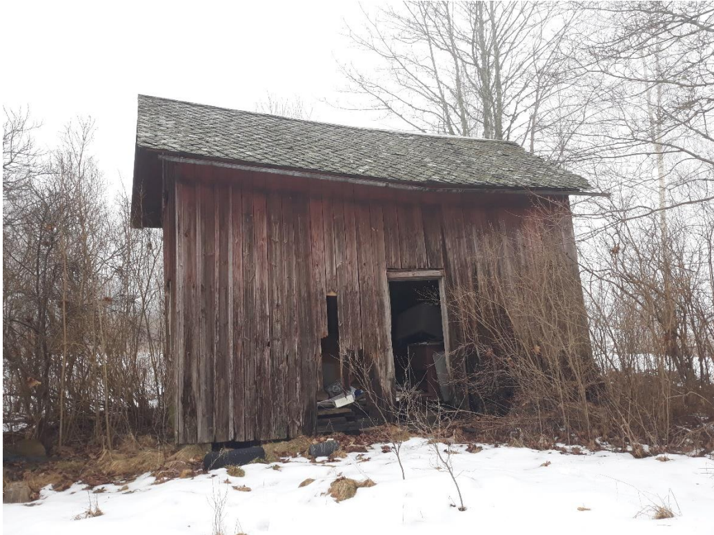
Byggnad vid område 12 som omfattas av föreläggandet.
