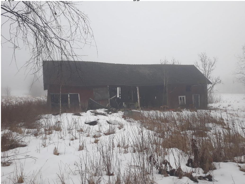
Byggnad vid område 13 som omfattas av föreläggandet.
