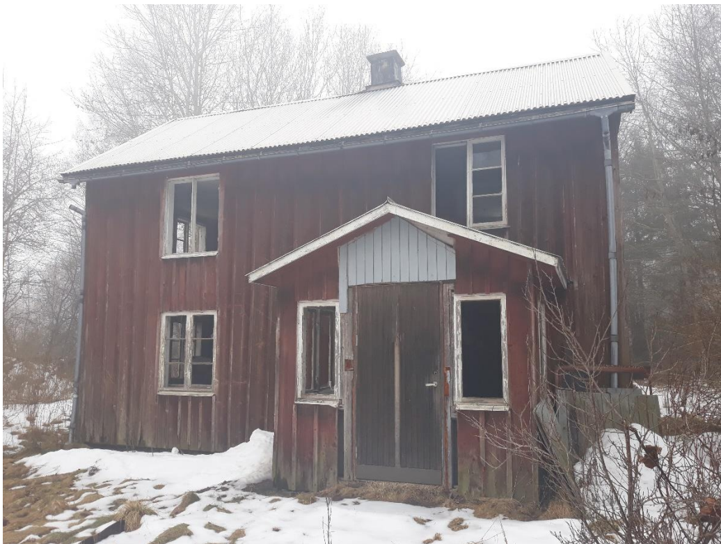
Byggnad vid område 12 som omfattas av föreläggandet.
