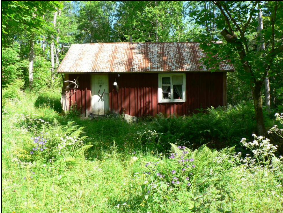
Nytterudsstugan sedd framifrån.
