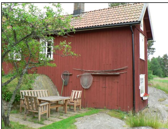
Byggnadens anslutning till berget.
