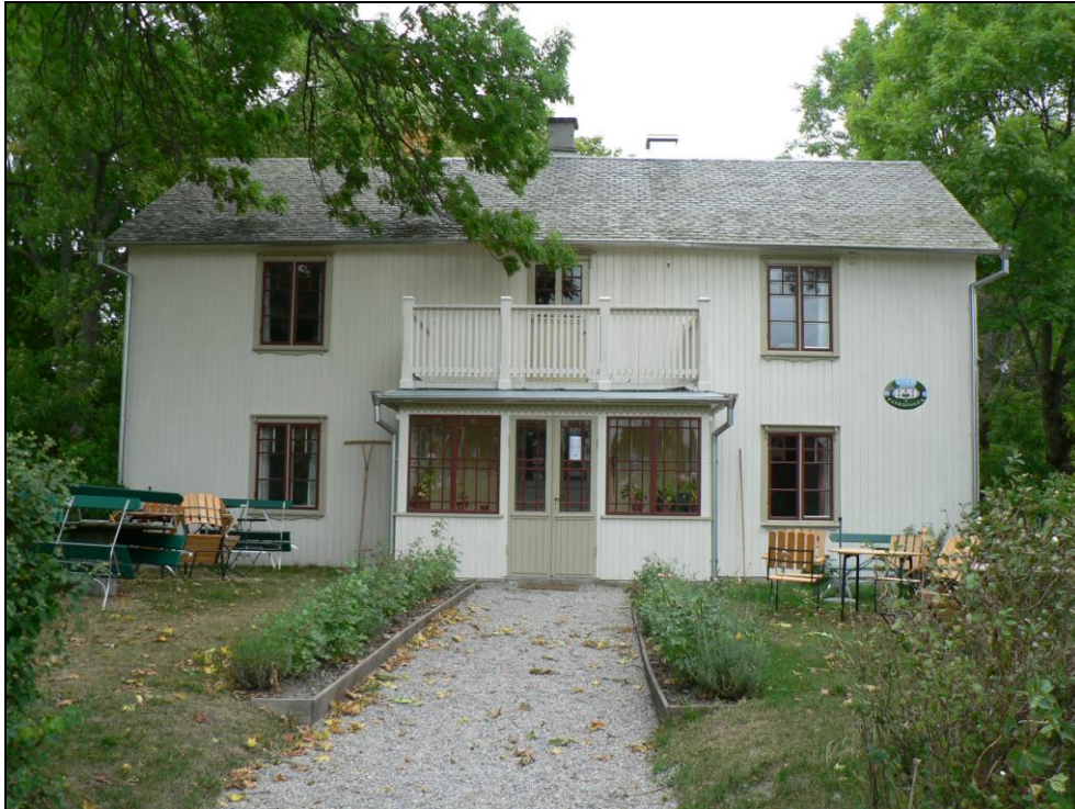
Entréfasaden med glasveranda.
