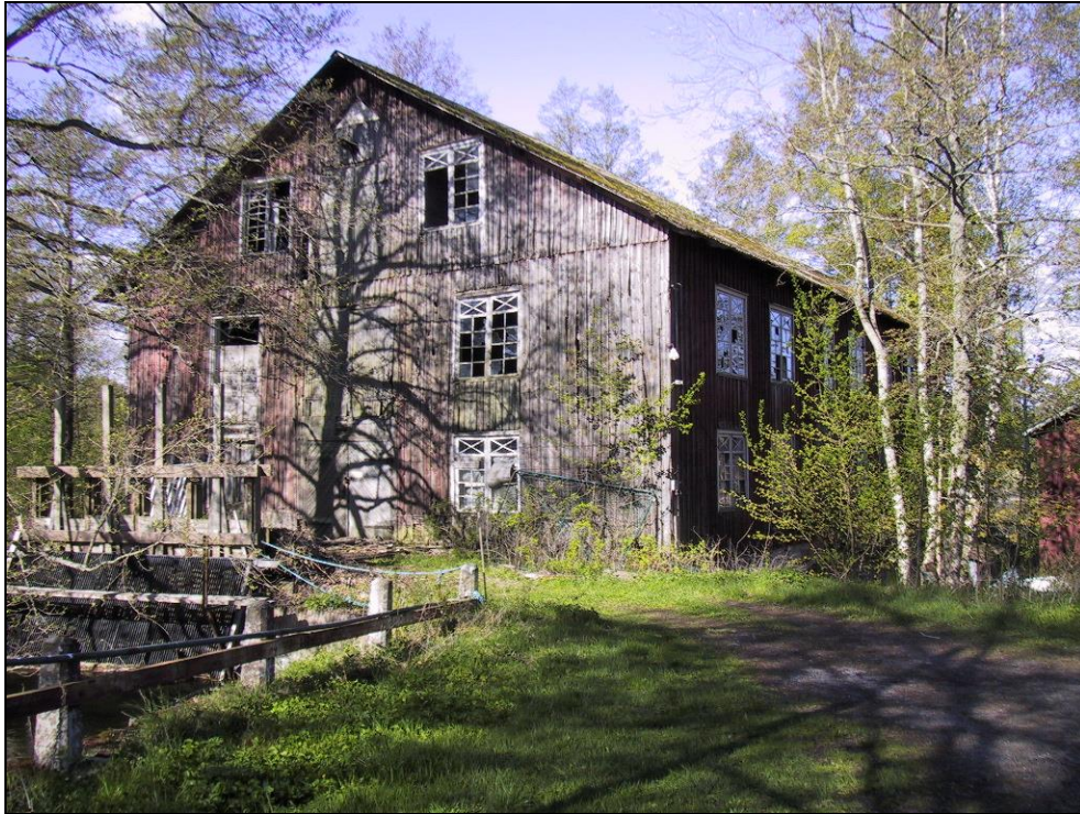
Sågverksbyggnaden i vårgårnska.
