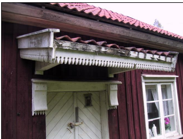
Skärmtaket med utsmyckning.
