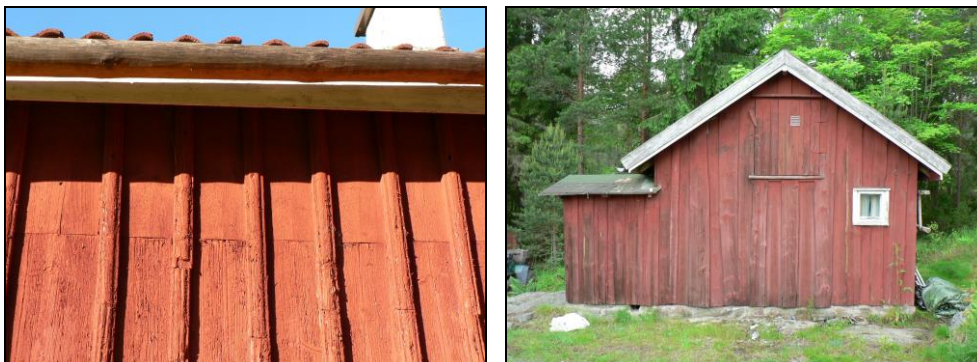
Träpanel kan se ut på många olika sätt. Skarvning av profilerad locklistpanel till vänster. Till höger okantad lockpanel.
