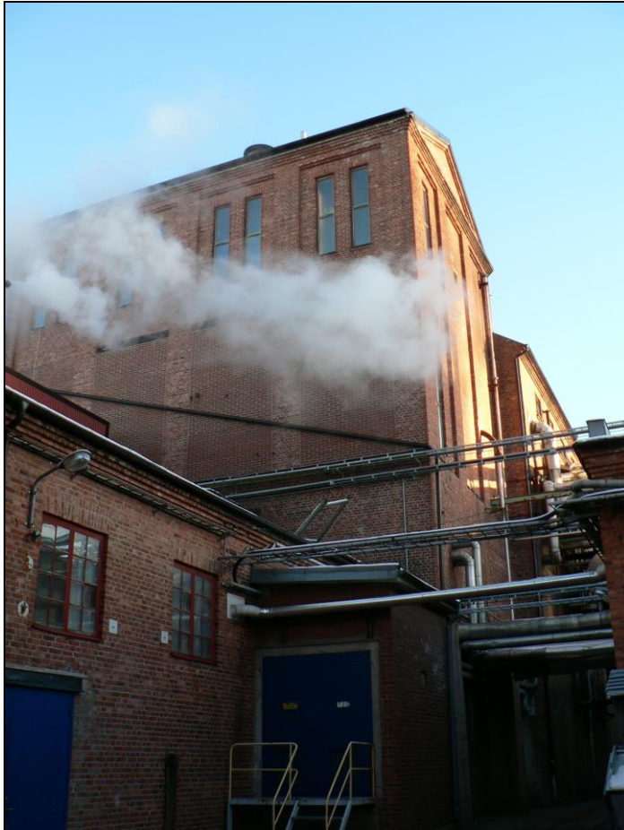
Kokeribygnaden med anslutande byggnadskroppar.
