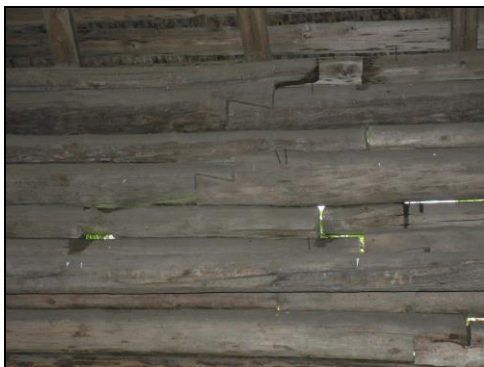
Timmerfogning i logen på Stora Liane.
