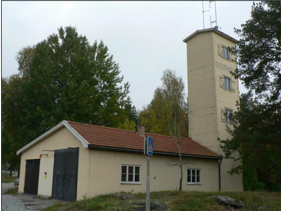
Brandstationen med dess torktorn och olikstora portar.
