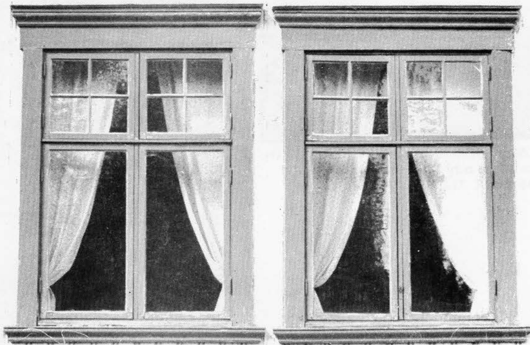
Krysspostfönster (losholz) med 4-delade övre lufter. 1920-tal. Sverkersbyn 1:1
