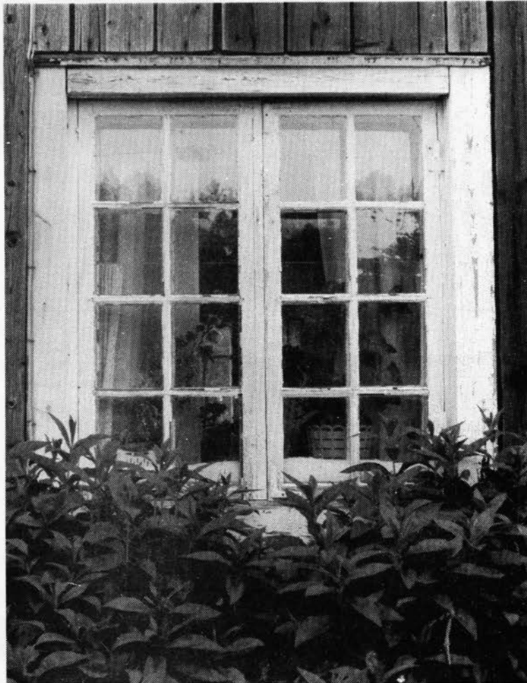
Mångspröjsade 2-lufts-fönster. Före 1800-talets mitt. Sandviken 1:2
