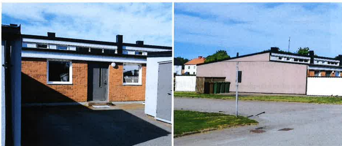
Norra fasaden med tegel samt östra fasaden med fibercementskivor.
