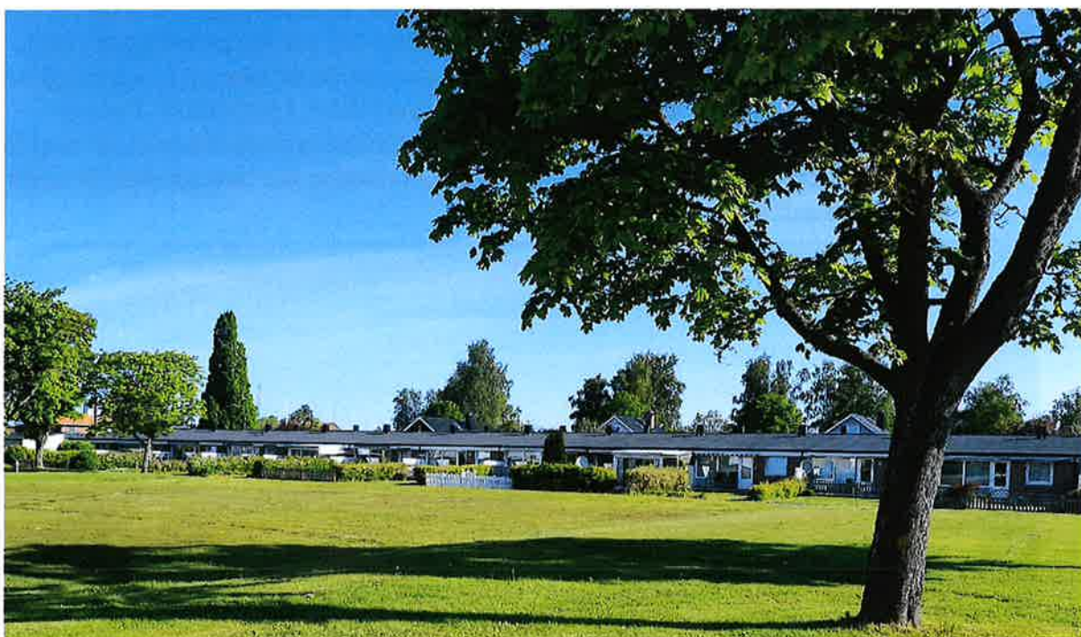
Södra fasaden på Korpen 1
