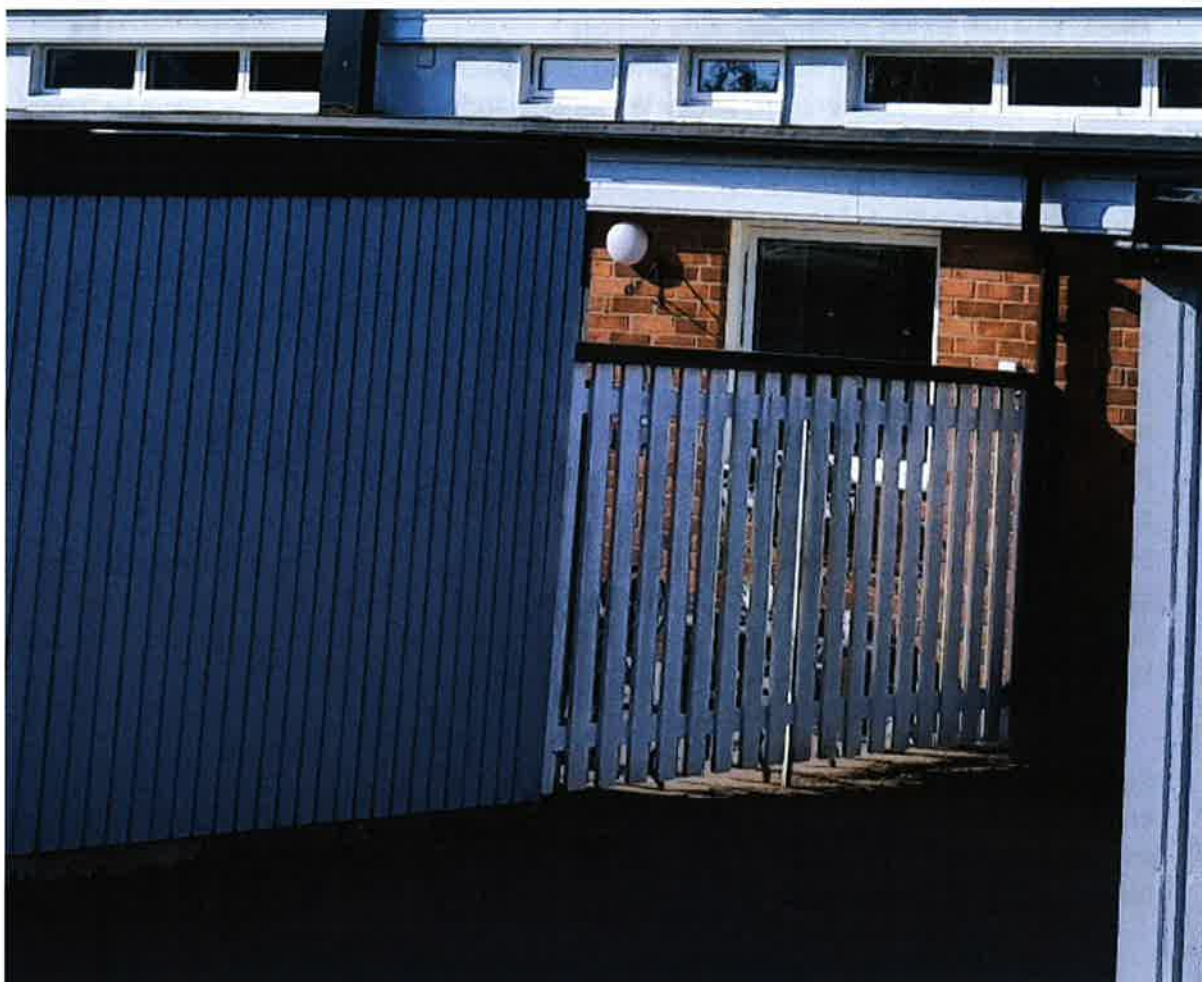
Plank mellan huvudbyggnad och komplementbyggnad
