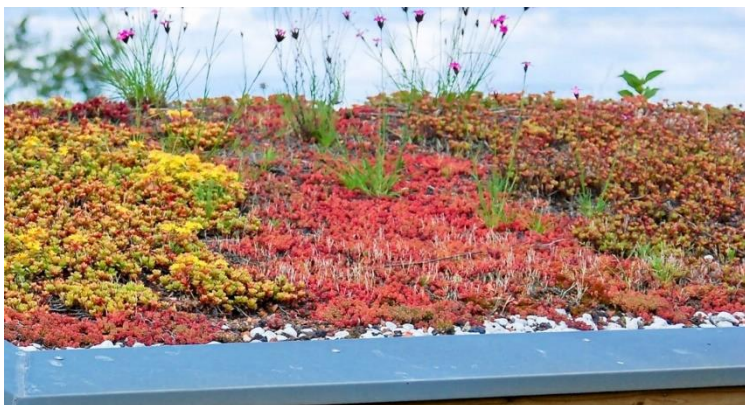
Sedumtak – hjälper till att fördröja regnvattenavrinning
