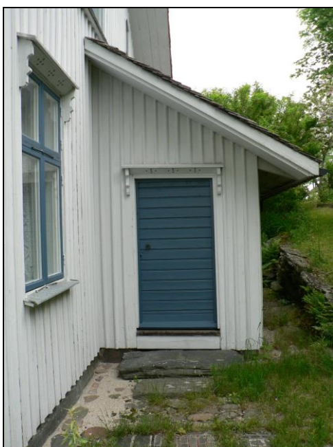
Överst till vänster ett äldre fönster med omsorgsfullt utformad omfattning. Överst till höger ljusspelet i gammalt fönsterglas. Nederst till vänster en enkel, men genomarbetad, sidodörr med liggande panel. Nederst till höger en fint arbetad pardörr till en glasveranda.
