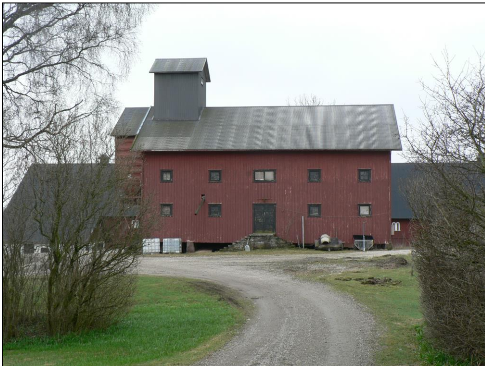
Det stora magasinet, med ladugården skymtande i bakgrunden.
