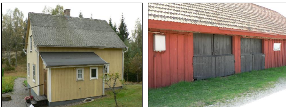
Huset till vänster har skiffertak av två olika typer. Även nocktäckningen är av skiffer. Till höger syns ett ladutak, där det äldre halmtaget är bevarat under teglet.
