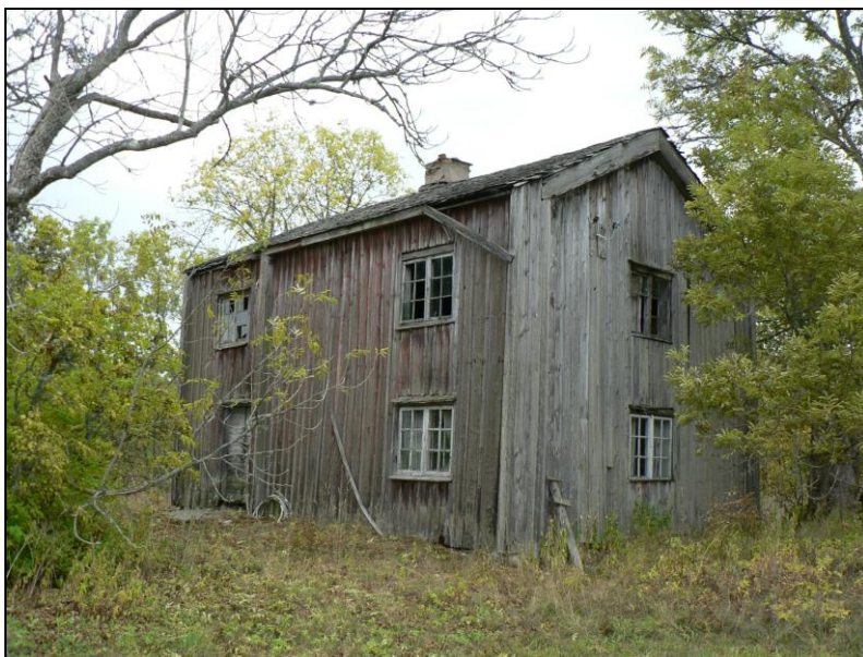
Dalslandsstugan sedd från vägen.
