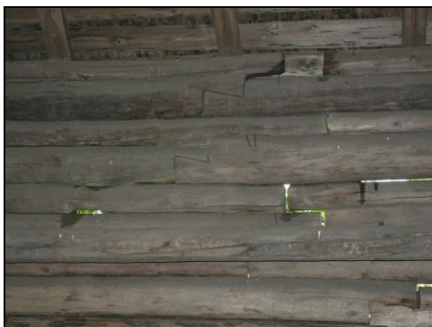
Timmerfogning i en loge med rundtimmer.
