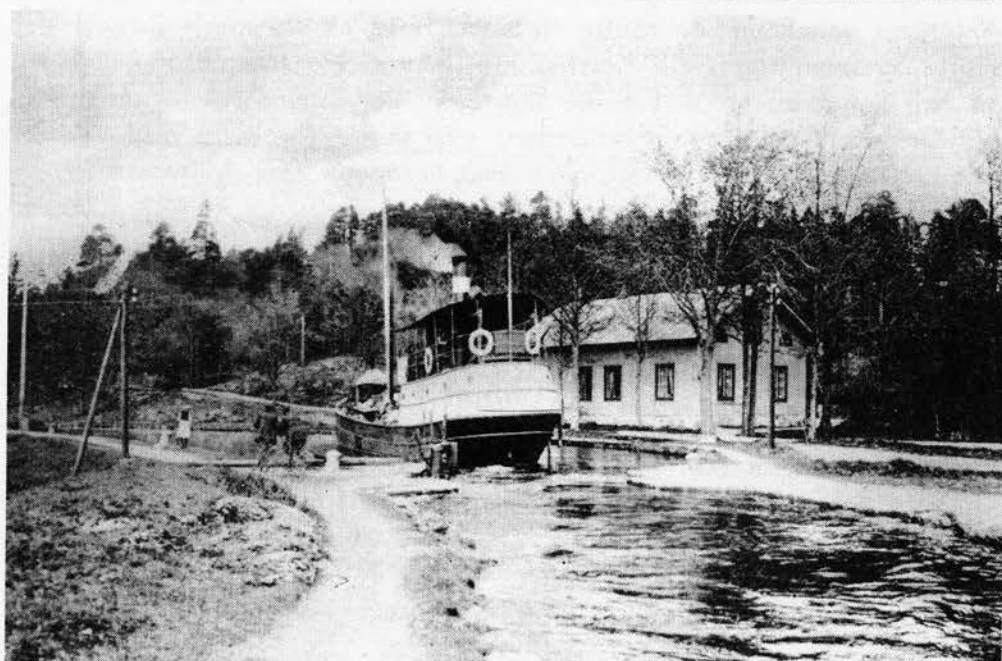
Ångare i Forsbo kanal med kanalkontoret i bakgrunden.
