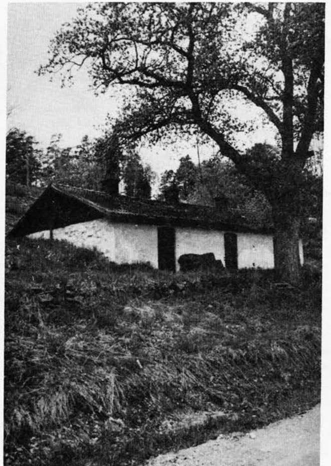
Stenkällare till arbetarbostad.
