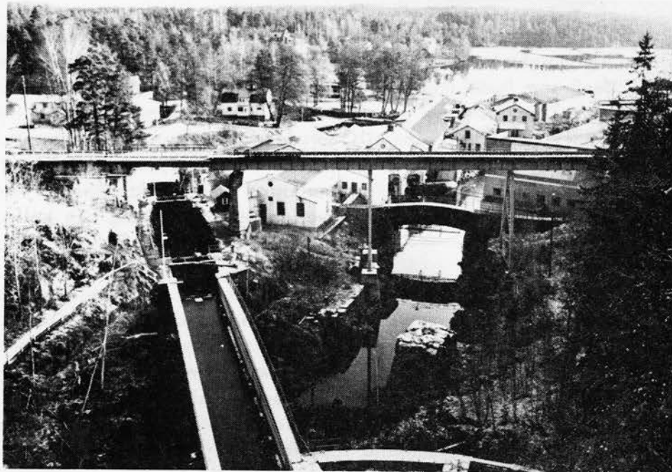
Håveruds bruk med akvedukt och järnvägsbro
