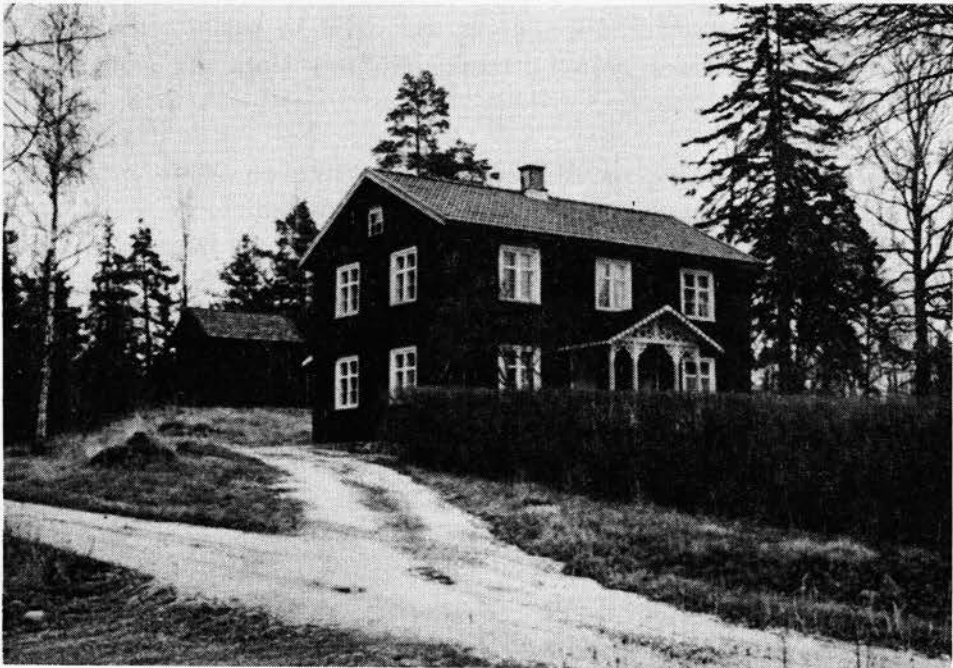
Välbevarad enkelstuga av Dalskogstyp
