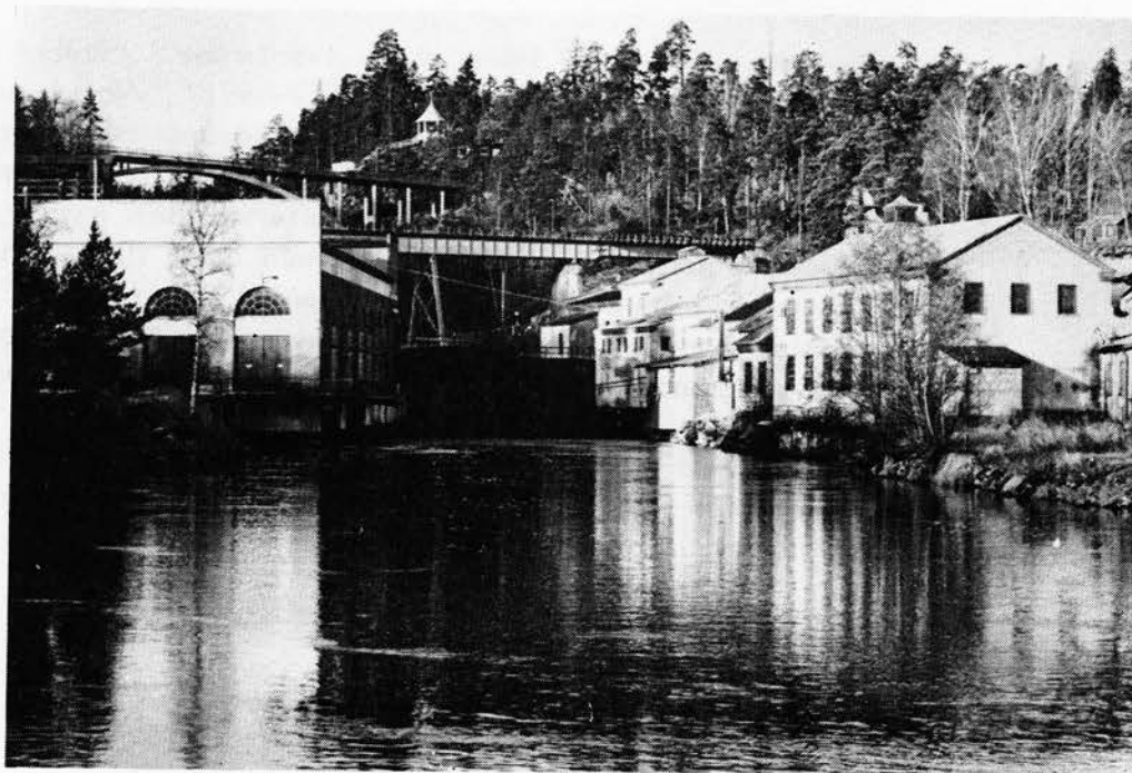
Håveruds bruk och kraftstation
