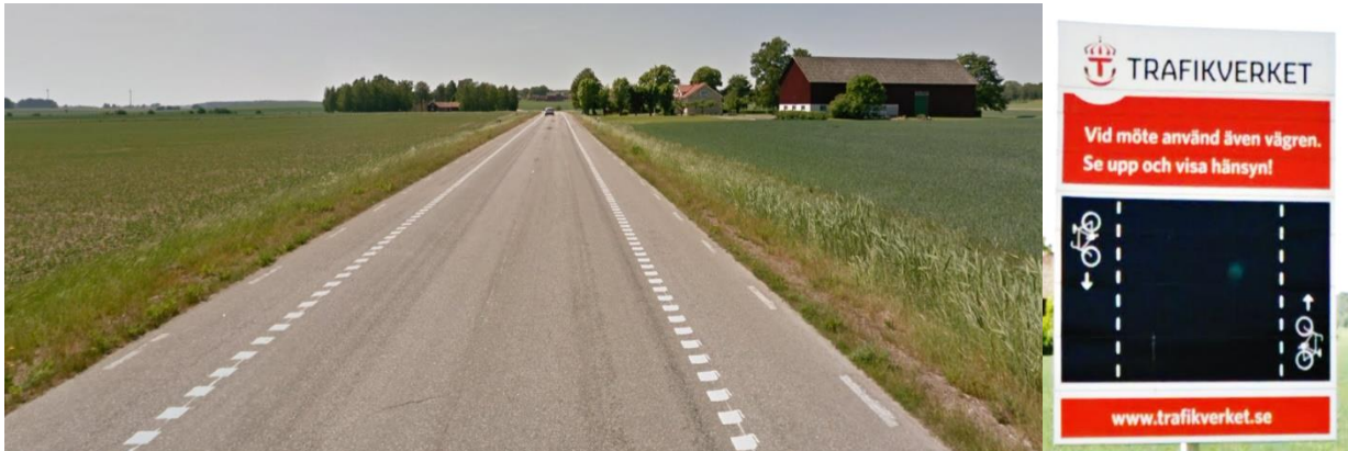
Figur 21. Illustration på lokalväg i kombination med cykelväg. Exempel från väg 2636 (Lidköping) med en total vägbredd på 7 m. Cykelväg 1,25 m (vardera sida) och bilväg 4,5 m, rekommenderad hastighet 60 km/h.
