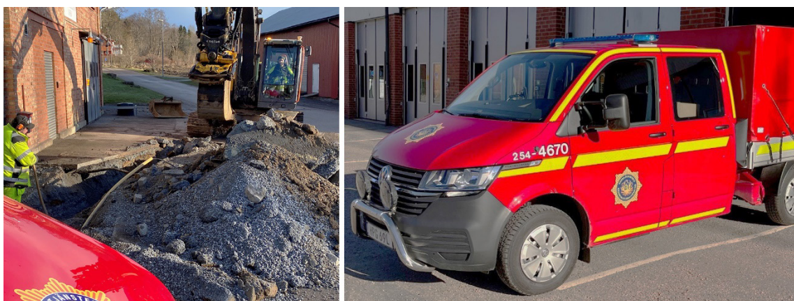
Till vänster: Vid Sjuntorps brandstation installerades en ny oljeavskiljare i början av året. Till höger: En ny stationsbil levererades till Melleruds brandstation.
