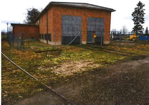
Figur 4. Omformarstationen, vy mot öster
