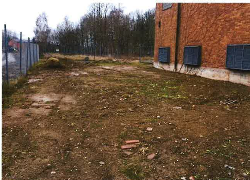
Figur 7. Omformarstationen från sidan
