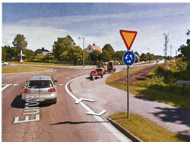
Figur 9. Spår omf avskuret av väg E45 i höjd med cirkulationsplats E45/Dalslandsgatan, riktning österut
