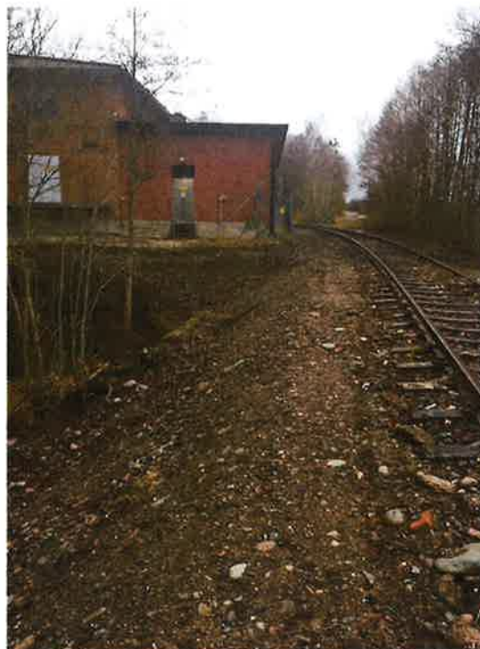
Figur 5. Omformarstationen och anslutande omformarspår, vy mot väster.
