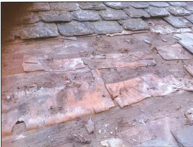
Björknäver som låg över takbrädornas springor. Foto Oliver Lagerlöf.
