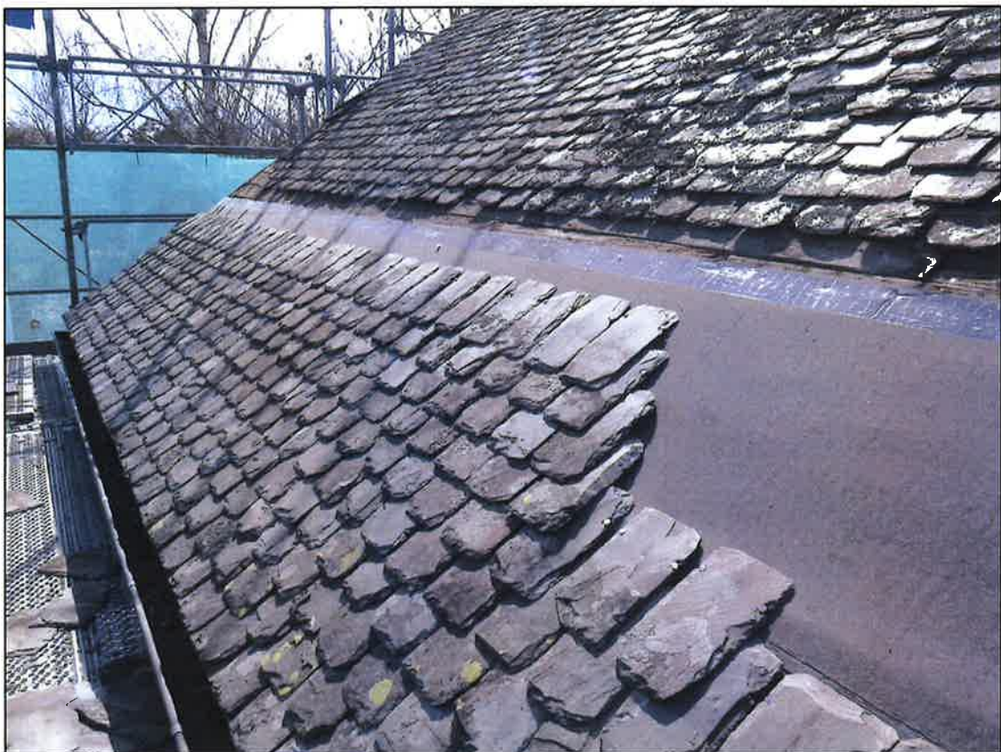
Baksidans takfall 2022-04-20. Nylagt skiffer med överlapp. Skifferplattornas storlek 15x25 cm. Foto Lars Bergström.
