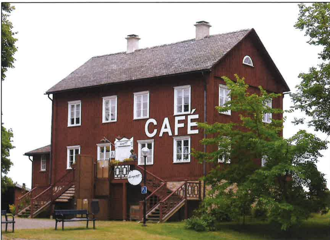
Cafébyggnaden från sydväst efter genomförda åtgärder. Foto Lars Bergström 2022-08-02.
