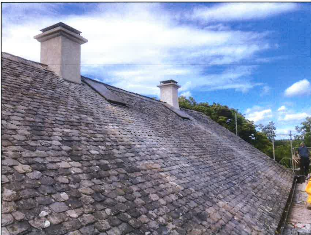
Baksidans takfall färdigställd. Foto Olli Lagerlöf juli 2022.
