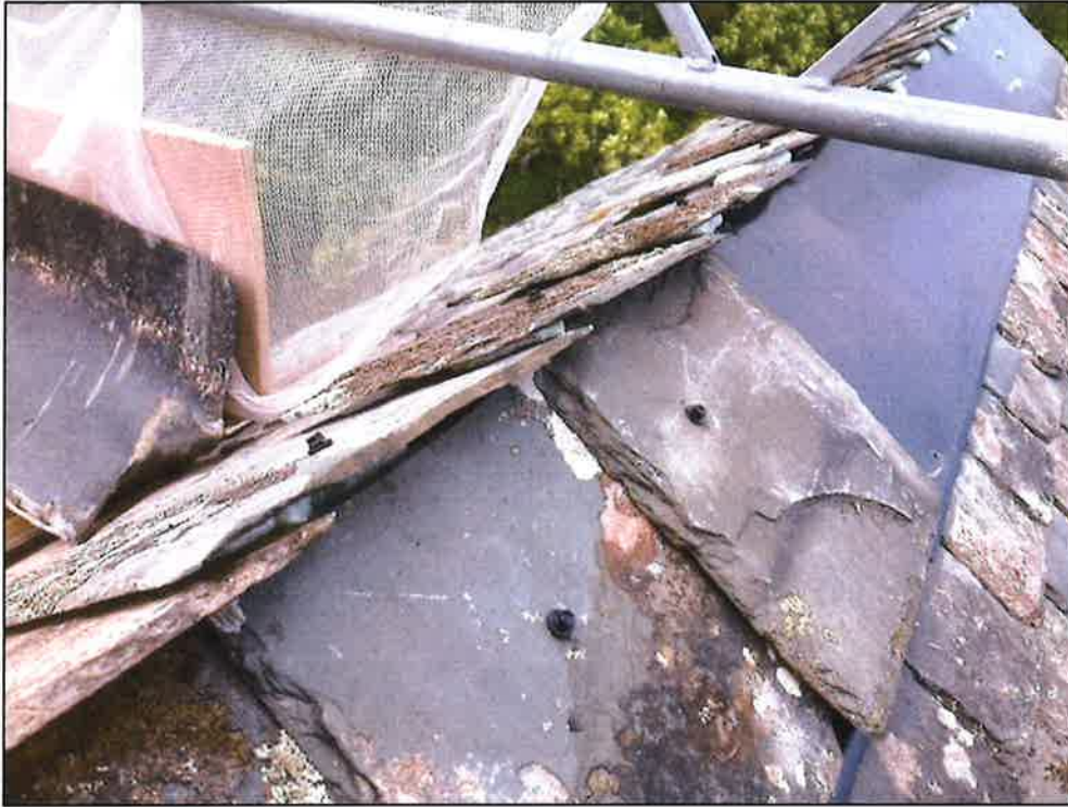
Del av nocken. Nockplåtar och överskjutande skifferplattor. Foto Olli Lagerlöf.
