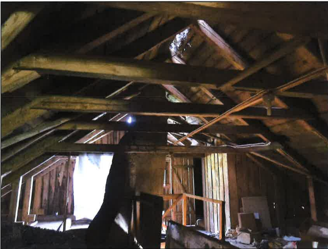
Vinden och takkonstruktionen med norra murstocken. Foto Lars Bergström 2022-07-06.
