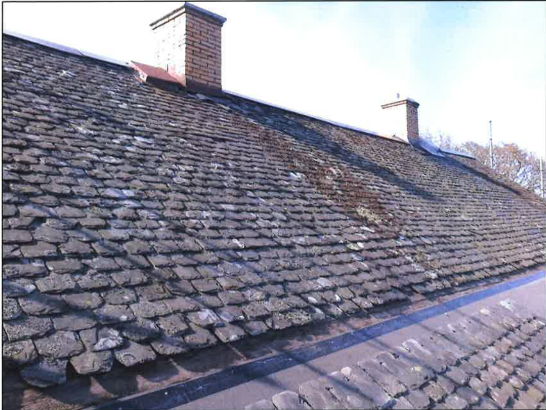
Baksidans takfall 2022-04-20. Nockplåt, skorstenar och takluckor före åtgärder. Nylagt skiffer i bildens nedre högra hörn. Foto Lars Bergström.
