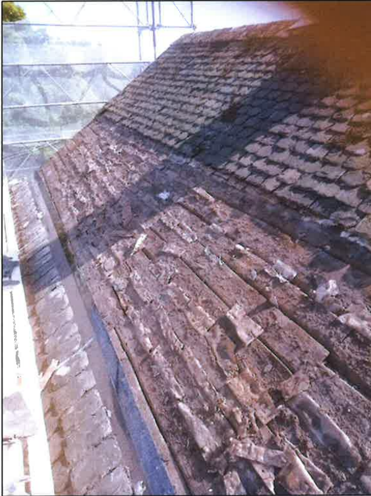
Björknäver som låg över takbrädornas springor. Foto Oliver Lagerlöf.
