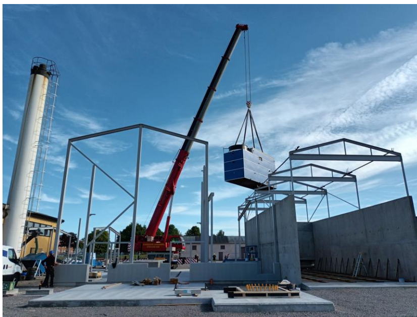
Lyft av nya flispannan som vägde 35 ton
