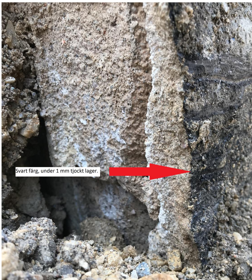
Figur 3. Väggsnitt som är bestruket med tunn svart färg.
