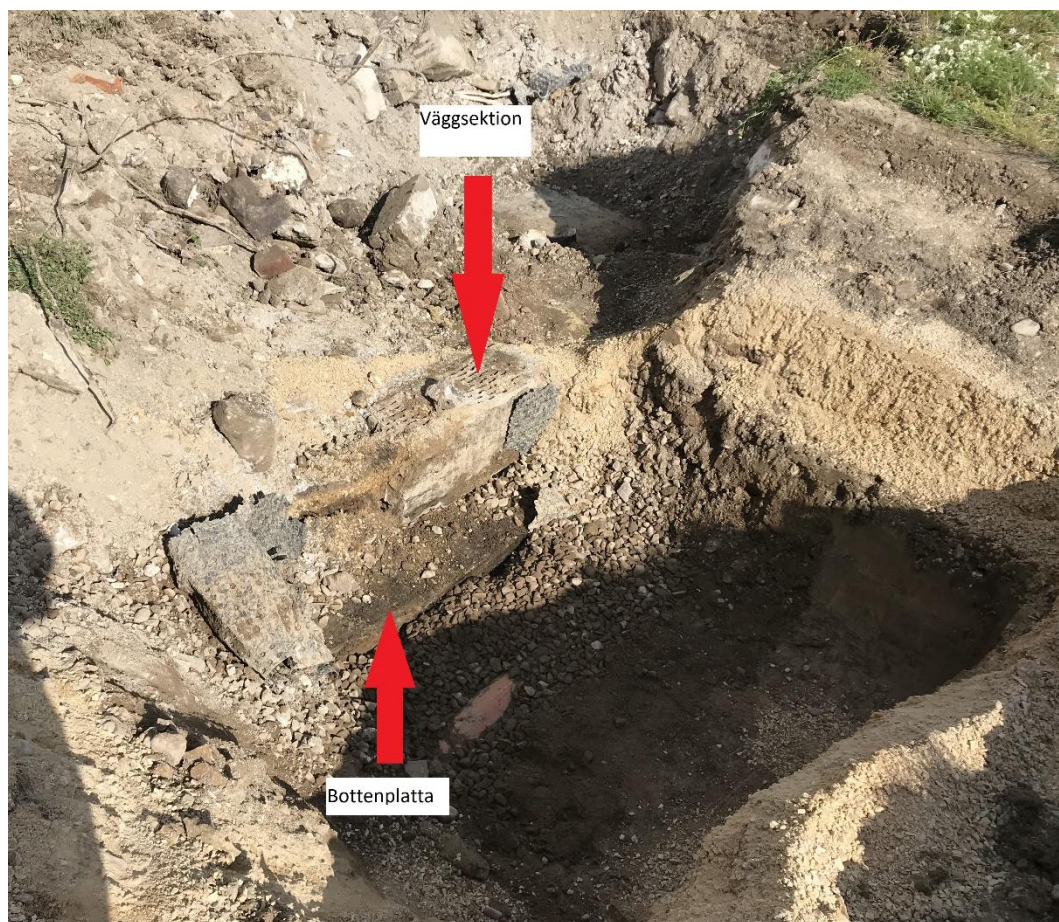
Figur 4. Husets bottenplatta och väggsektion.
