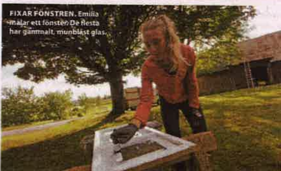
GRUNDJOBBS. Renoveringen av det gamla tjänstefolktrummet har påbörjats.
