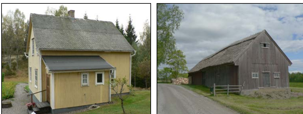
Huset till vänster har skiffertak av två olika typer. Även nocktäckningen är av skiffer. Till höger syns ett bevarat halmtak.
