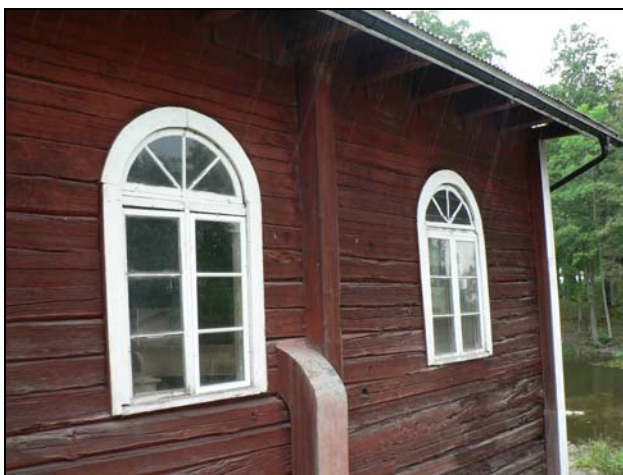
Fönstren. Överdelen på det högra är ett blindfönster.
