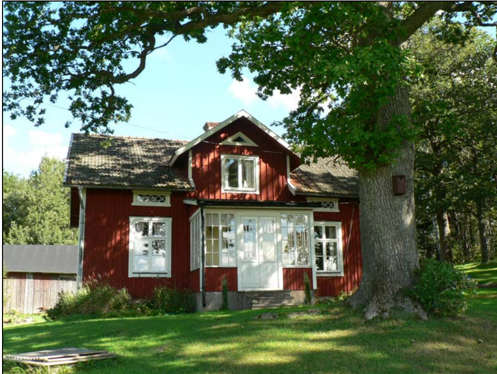
Boningshuset, med ladugården skymtande bakom.
