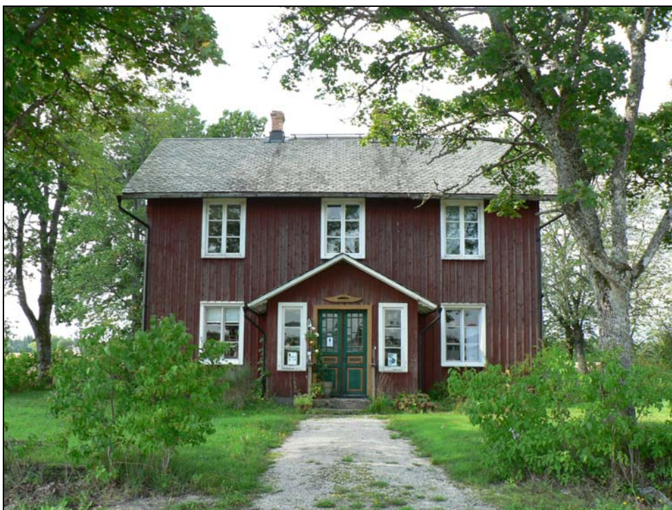
Det före detta kommunhuset sett från vägen.
