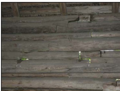
Timmerfogning i loge med rundtimmer..
