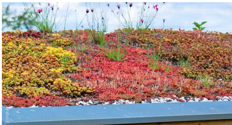
Sedumtak – hjälper till att fördröja regnvattenavrinning
