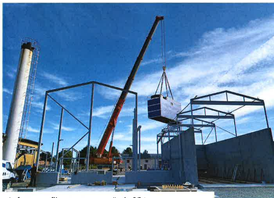
Luft av nya flispannan som väger 25 ton
