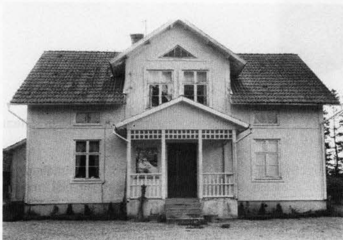
Bostadshus (1929), bostadshus (1900), lagård (1929), magasin (1935), garage (1900-1930), uthus (1950-90), maskinhall (1980-t).
