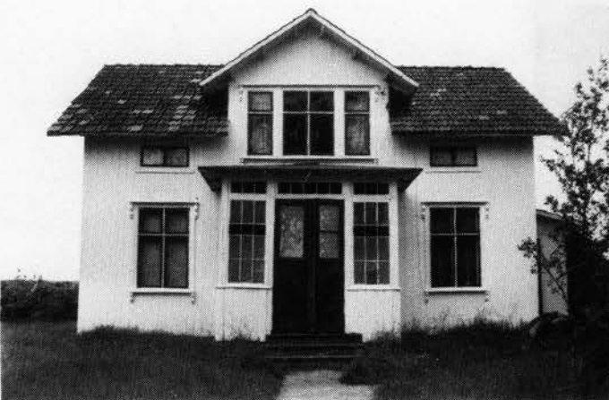
Bostadshus (1900), uthus (kring 1900), lagård (kring 1900), uthus (kring 1900).
