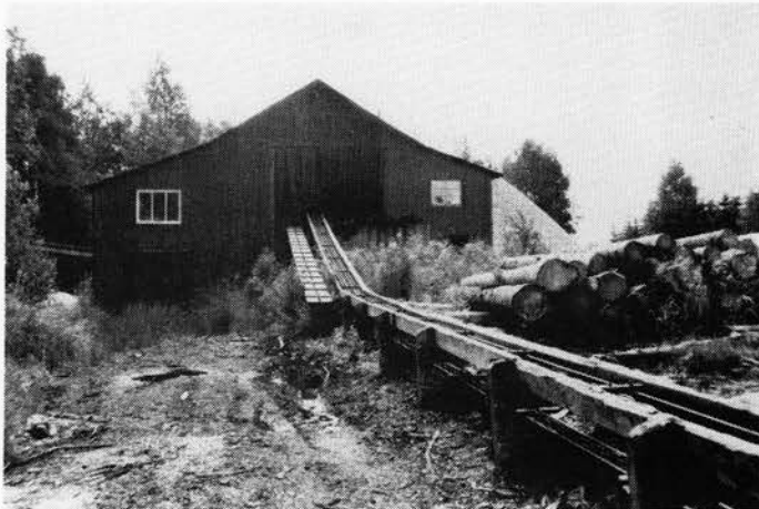
Sågverk (1928, om- och tillbyggt 1935–1951).
