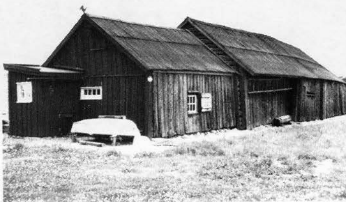
Lagårdsbyggnad, Rådane Norra 1:71 i Grinstad.
