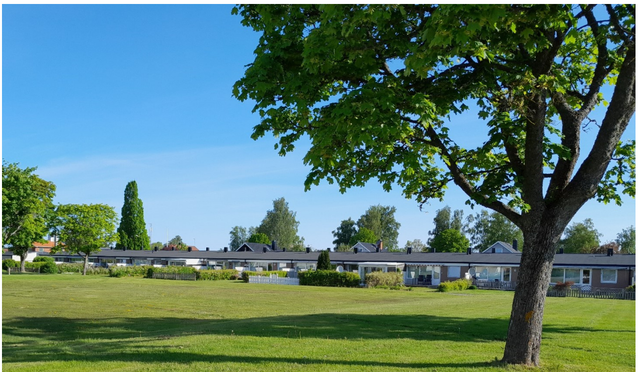
Södra fasaden på Korpen 1
