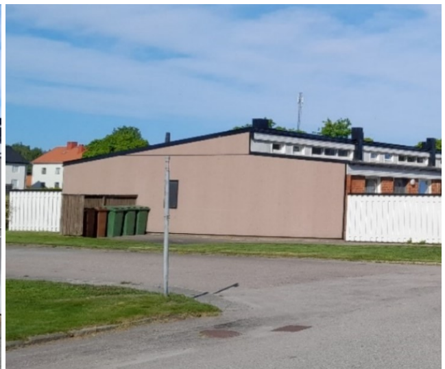
Norra fasaden med tegel samt östra fasaden med fibercementskivor.
