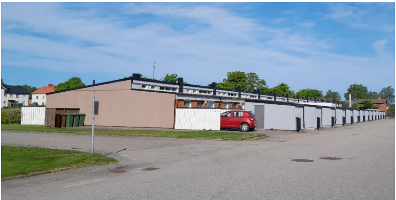
Pulpettakets utformning med fönsterband och siktlinje som fortsätter över komplementbyggnadernas tak.
