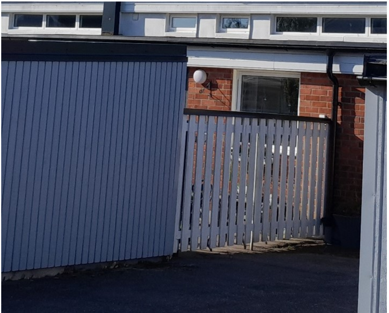
Plank mellan huvudbyggnad och komplementbyggnad
