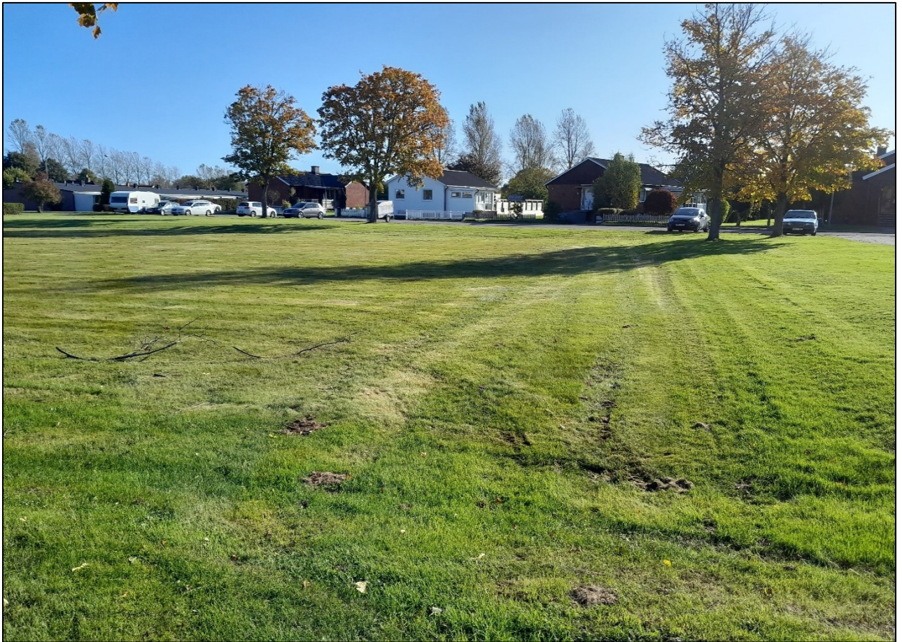
Grönområdet Emmas Hage är en fördjupning som samlar och infiltrerar dagvatten.
