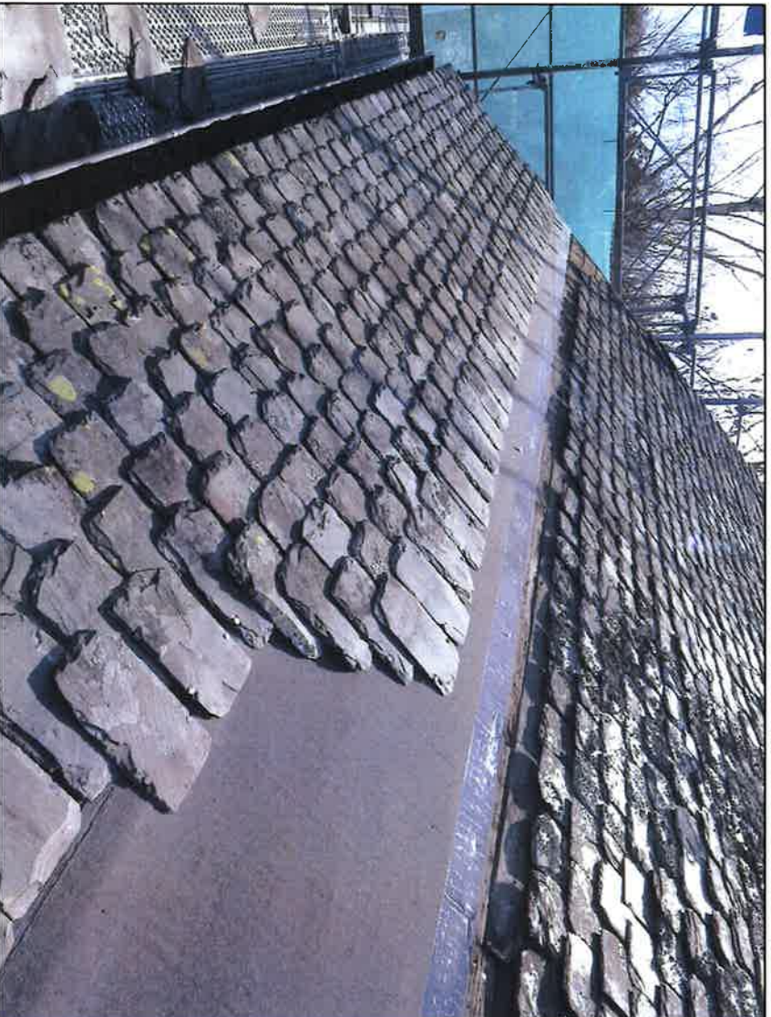
Baksidans takfall 2022-04-20. Nylagt skiffer med överlapp. Skifferplattornas storlek 15x25 cm. Foto Lars Bergström.
