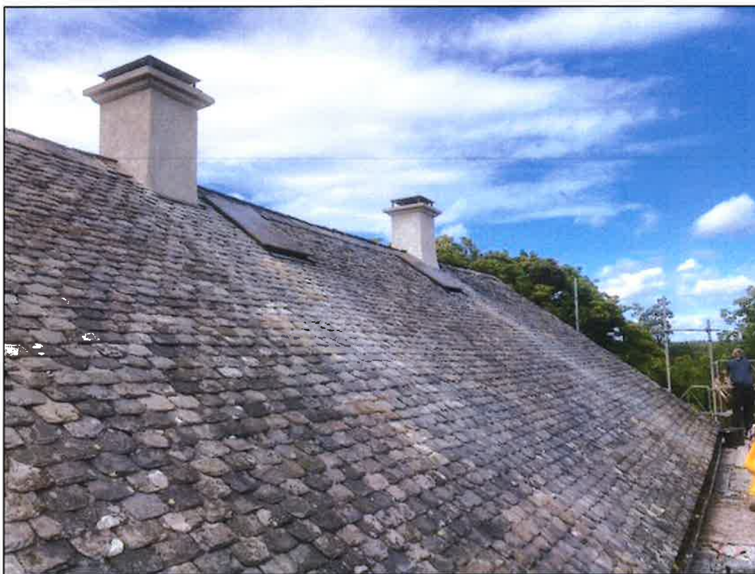
Baksidans takfall färdigställd. Foto Olli Lagerlöf juli 2022.
