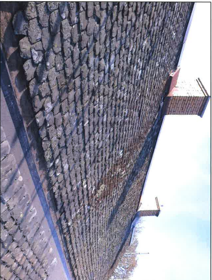
Baksidans takfall 2022-04-20. Nockplåt, skorstenar och takluckor före åtgärder. Nylagt skiffer i bildens nedre högra hörn. Foto Lars Bergström.
