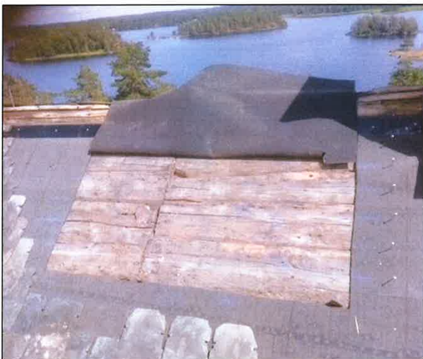
Ytan (ca 1,5 kvm) för rekonstruktion av näverläggningen på taket. Vidnocken t v om södra skorstenen på framsidan. Foto Oliver Lagerlöf.
