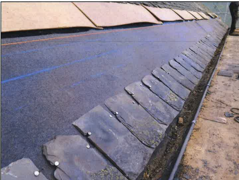
Nedersta raden av skifferplattor på framsidan lagd. Foto Lars Bergström 2021-06-03.
