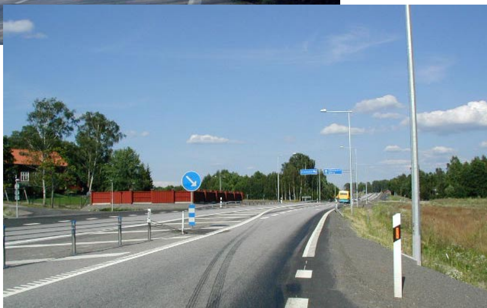
Anslutningen av väg 2258 norr om Åmål
