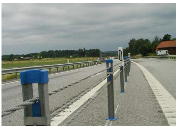
Mitträcke och växlingssträcka på mötesfri landsväg mellan Åmål och Säffle
