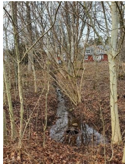
Galler vid inloppet till kulverten vid Mörtetjärnen (till vänster) samt kupolbrunn vid inloppet till dagvattensystemet vid före detta Kroppefjällshemmet (till höger).
