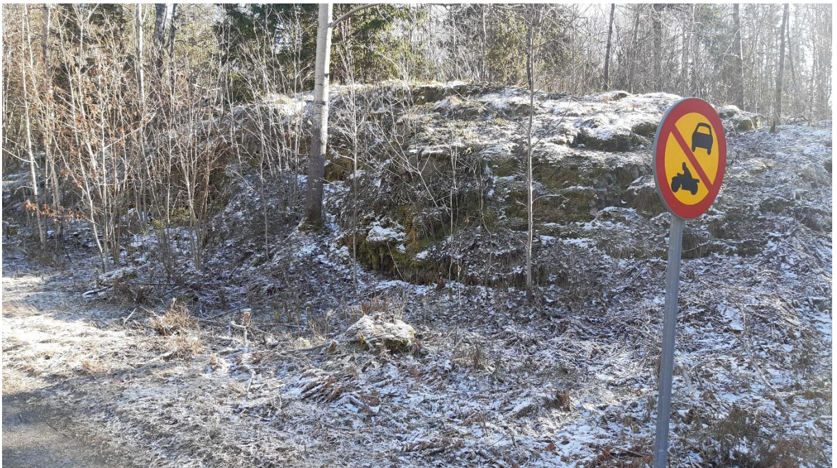
Figur 6. Bergslänt södra delen
