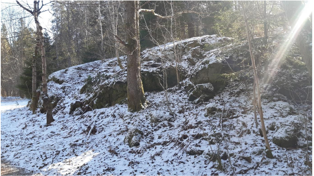
Figur 3. Bergslänt norra delen
