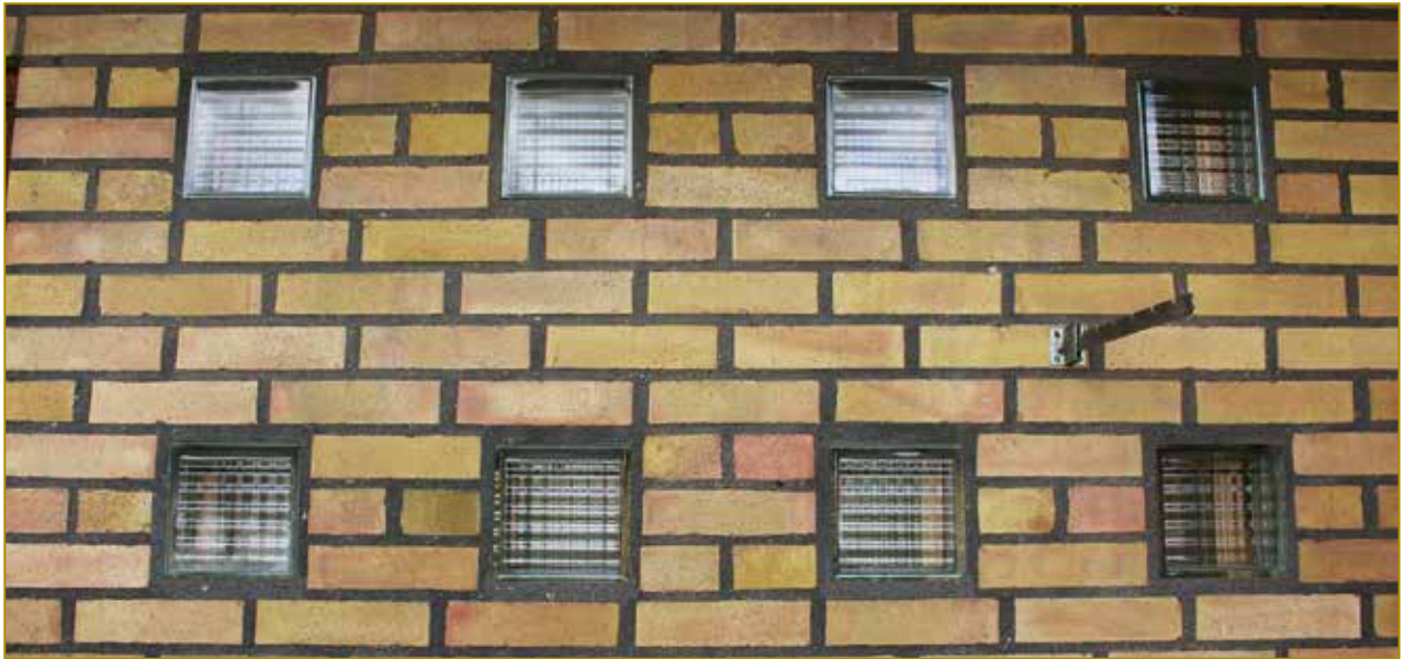
Fasaddetaljer av glasbetong vid entrén.
