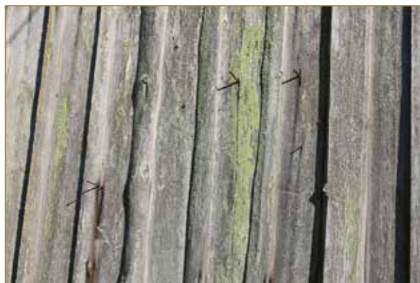
Källstorp 1:25. Äldre locklistpanel.
