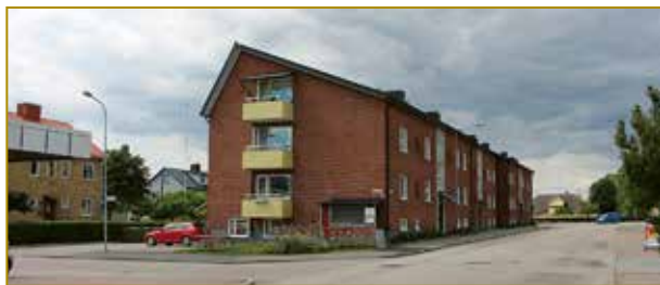
Huldran 9. Den asymmetriska takformen är typisk för 1950-talets bostadsarkitektur. Notera även kryssmönstret som bildas av det så kallade munkförbandet.
