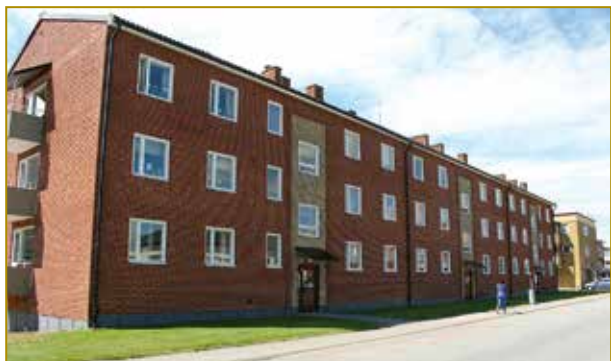
Älvan 11. Flerbostadshus byggt 1960.
