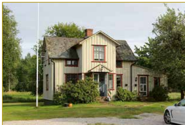
Skogserud, manbyggnaden uppförd 1933.
