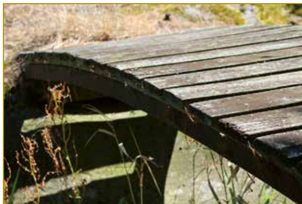
Sunnanå 2:16. Äldre takbjälkar från kupévagnen har återanvänts som brobalkar.
