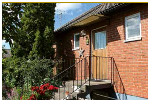
Bävern 9. Notera entrépartiet med betongtrappa och svarta järnräcken, den smalspontade och glasade dörren och inte minst det utskjutande skärmtaket av plast. Enkla detaljer bygger tillsammans ofta en kulturhistoriskt värdefull karaktär.
