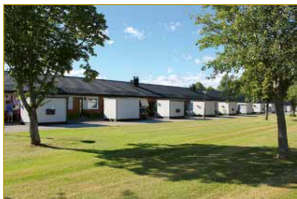
Ugglan 8, entréfasad med fristående förråd i panel.
