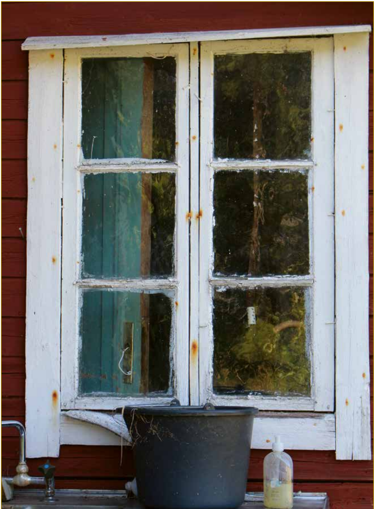
Källstorp 1:25, munblåsta fönster på boningshuset.
