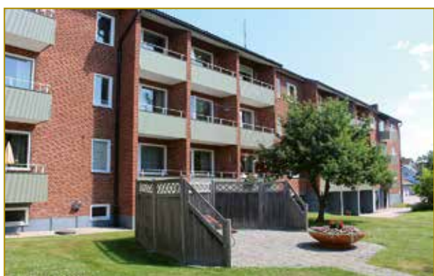
Älvan 11. Flerbostadshus byggt 1960.
