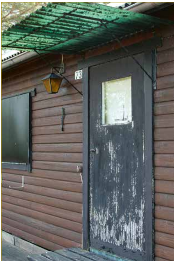
Jonsbråna 1:2. Entréparti på fritidsstugan.
