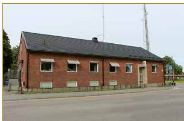
Liljan 6 – polisstation. Fasaden över källarfönstren är dekorerad genom murning i rullskift.
