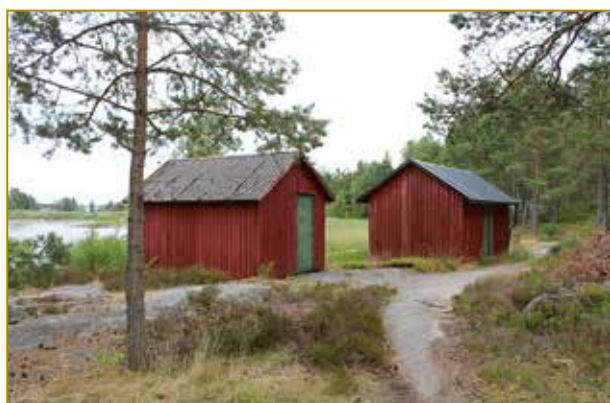
Ängenäs 2:5. Två av bodarna med faluröd panel och tak av plåt och eternit.
