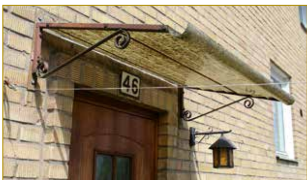
Bevarat skärmtak i järn och plast. Under hänger en matchande ytterlampa. Entrédörren är inte ursprunglig.
