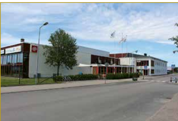
Rådahallen med sim- och träningsanläggning.
