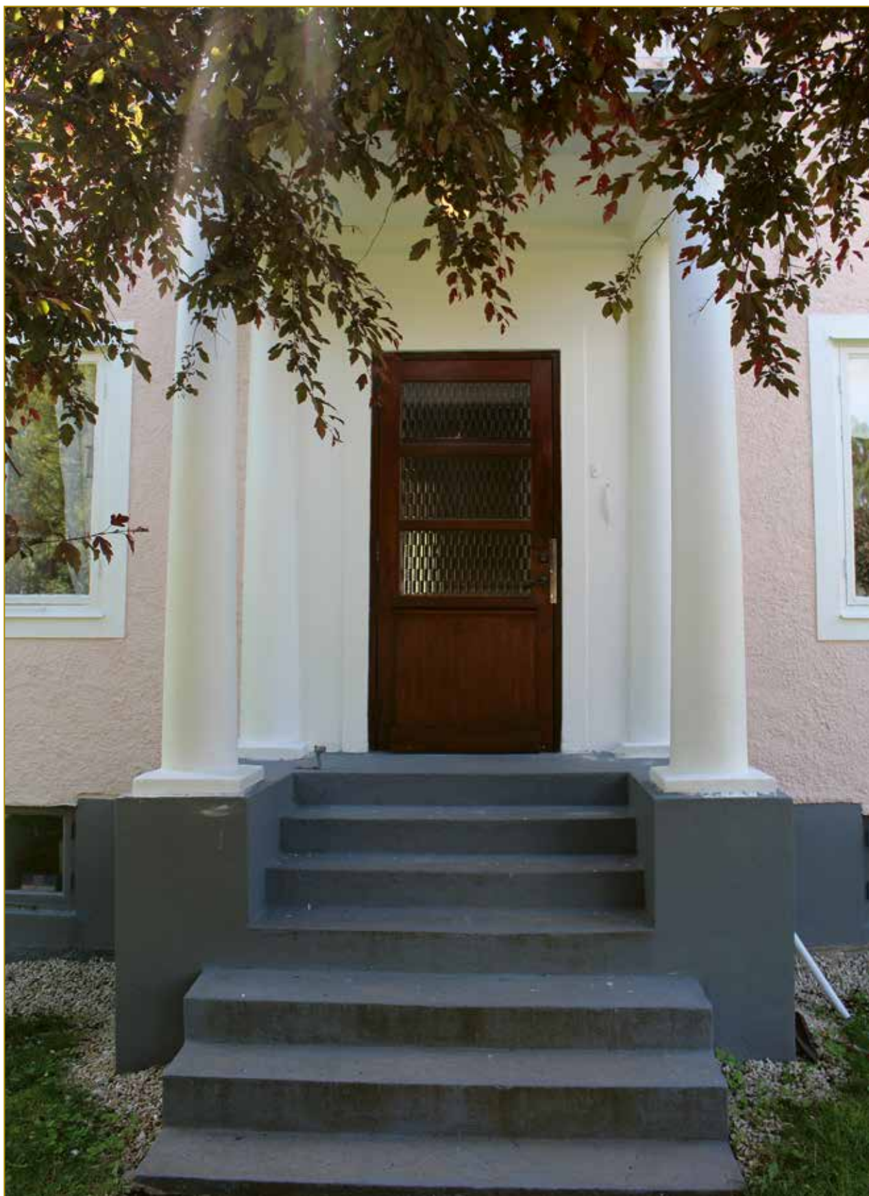
Vallen 3 – förstuvist med kolonner och en glasad entrédörr.
