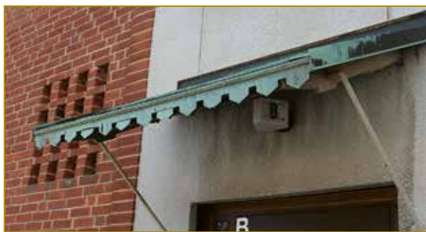
Skärmtak i plåt med baldakinform.
