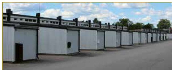
Förrådsbyggnader i målad panel. För det kulturhistoriska värdet är materialvalet och en enhetlig färgsättning viktig att bevara.
