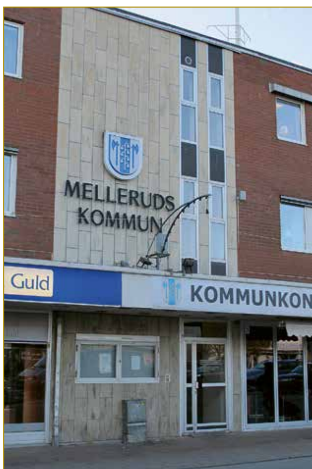
Marmorplattor utsmyckar fasaden på kommunhuset.
