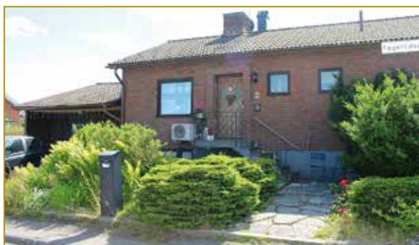
Björnen 15. Garaget är tillbyggt. Husets fasad är i övrigt ursprungligt skick.
