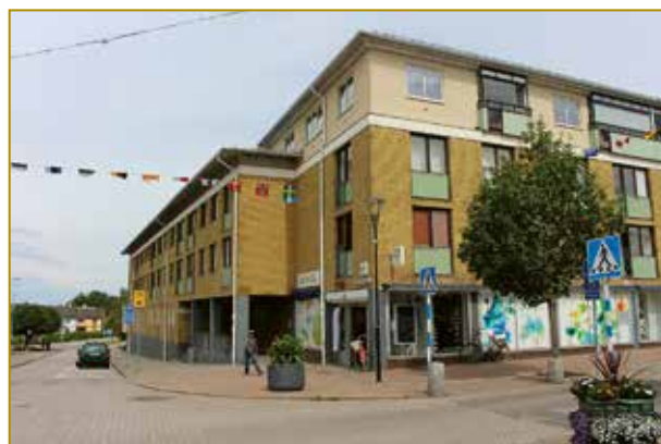
Norra Kungsgatan i riktning mot norr fotograferad från Köpmantorget.
