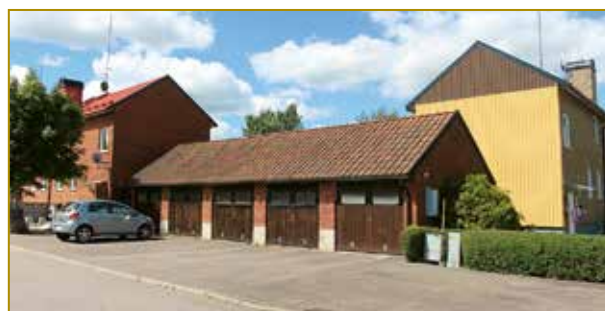
Garaget som byggdes till 1966 är fortfarande i ett välbevarat ursprungligt skick. Fasaderna på gaveln till höger är tilläggsisolerad och klädd med plåt.
