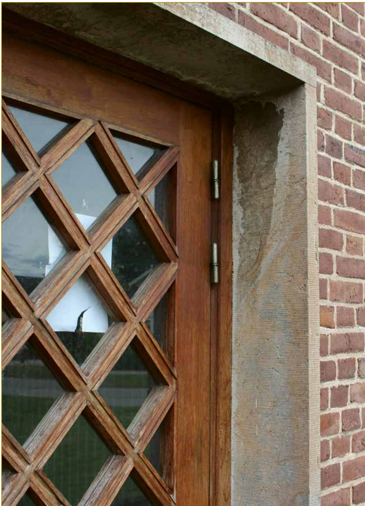
Linden II – före detta kontors- och disponentbostaden.
