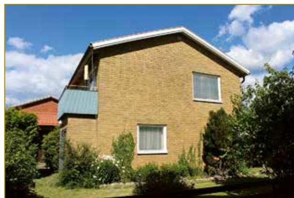
Kvarteret Duvan. Sydfasad.
