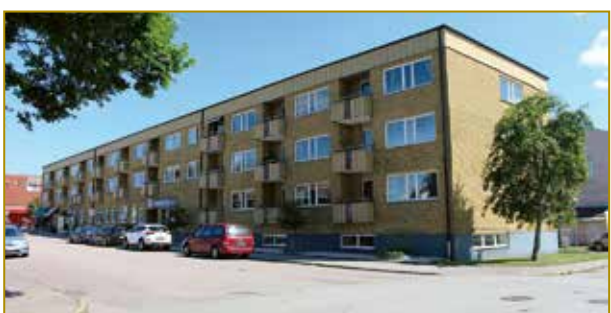
Älvan 11. Flerbostadshus byggt 1969.
