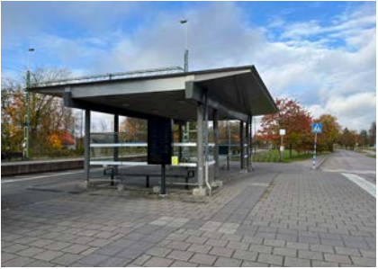
Vindskydd på plattformen.
