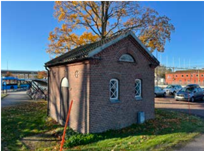
Transformatorstation vid stationshuset.
