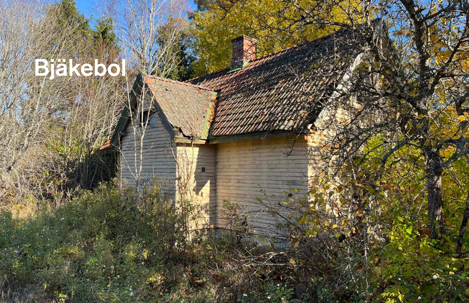
Bjäkebols banvaktstuga. Fasaden mot spåret med utbyggt mittparti, saknar helt fönster och dörröppningar.
