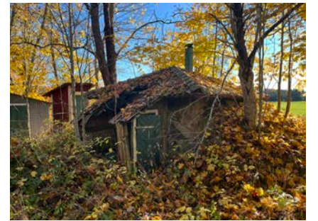
Jordkällare i sten under tegeltak.
