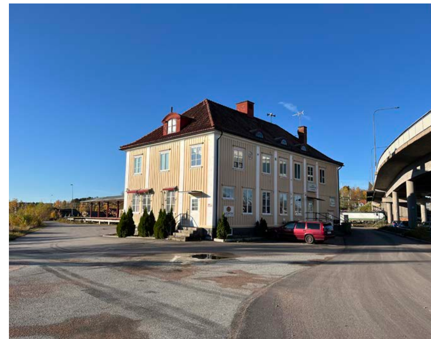
Åmål Östra, stationshuset från S.
