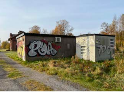
Mellan stationshuset och lastområdet står två teknikbodar.
