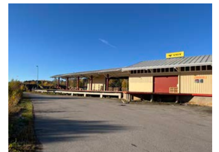
Sammanbyggt med Åmål Östra station finns ett godsmagasin.
