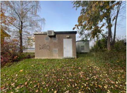
Norr om stationshuset finns ett teknikhus med fasad av frilagd ballast.
