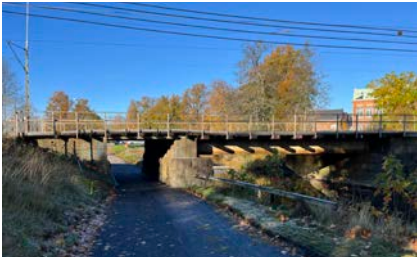
Bron med passage under spåren.
