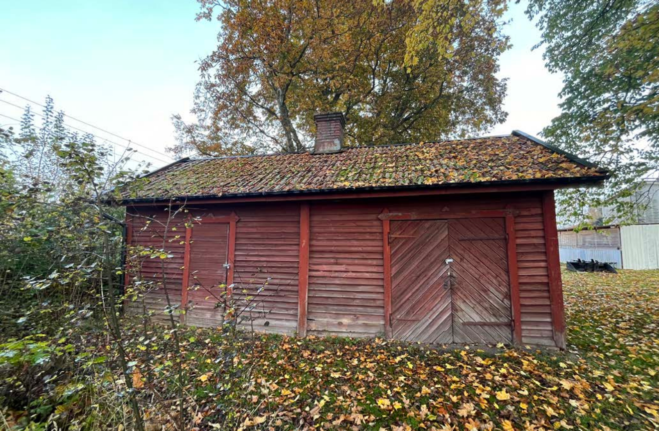
Norr om stationshuset står ett brygghus med fasad av rödfärgad liggande panel på förvandring. Huset täcks av ett tegeltak.
