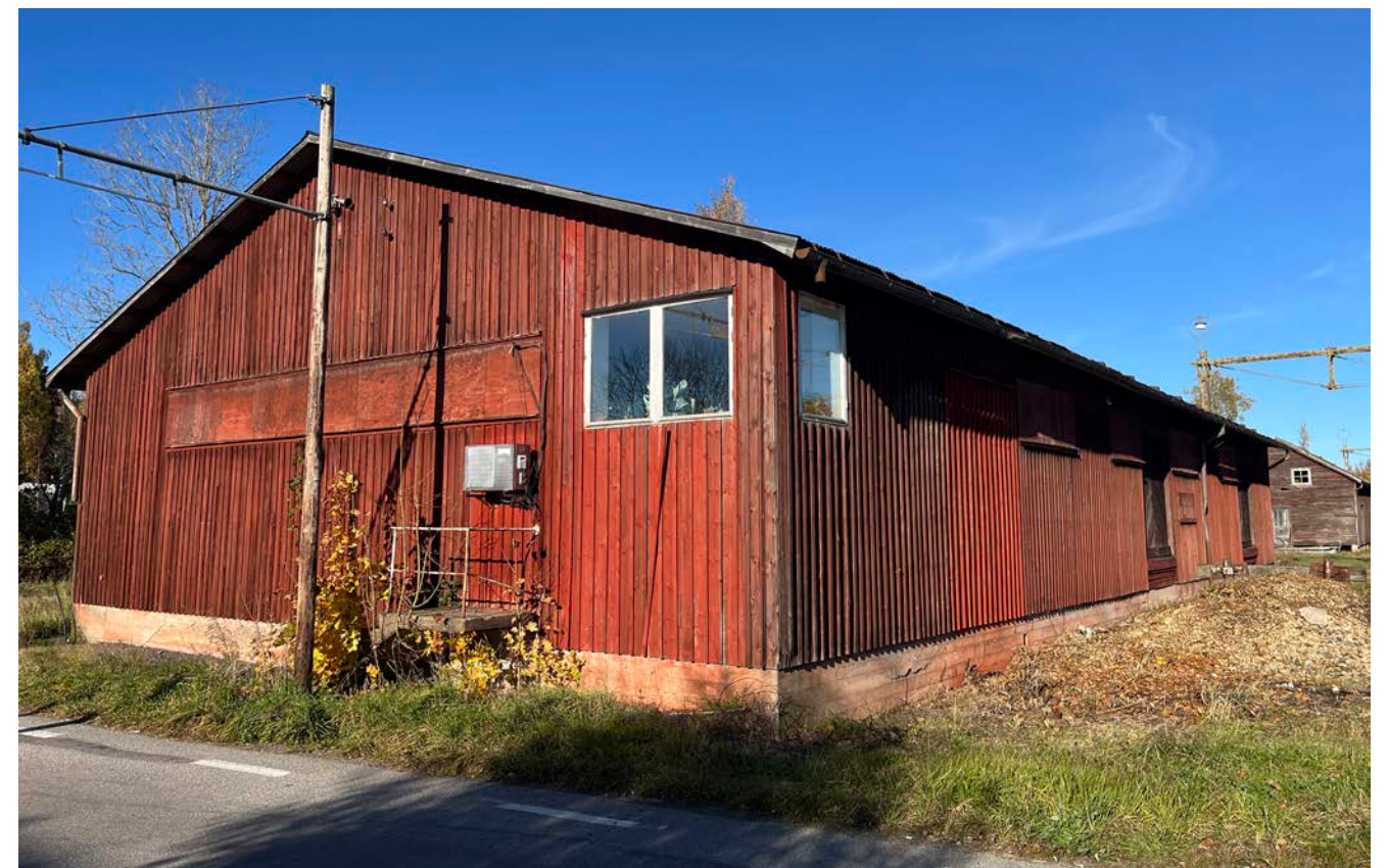
Södra, större magasinet.
