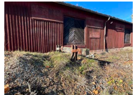
Ett stickspår går framför de båda magasinsbyggnaderna och slutar i en stoppbock
