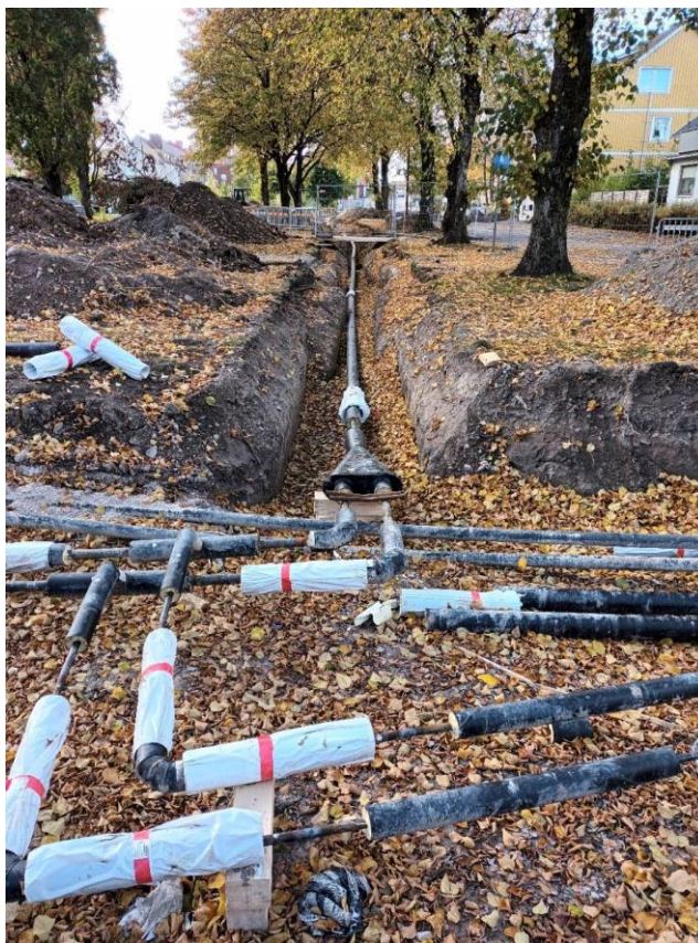
Utbyggnad kulvernät Mellerud
