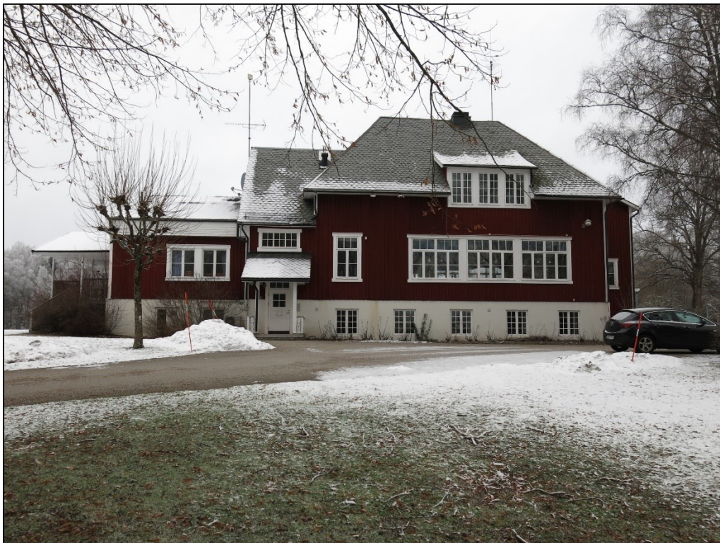
Figur 14. Centralbyggnaden är en byggnad i två våningar med valmat, skiffertäckt tak.
