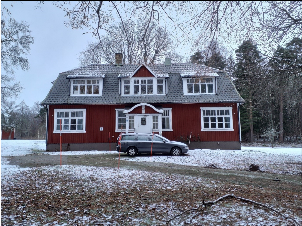
Figur 30. Paviljong 8, Backamo, är liksom paviljong 9 uppförd i två våningar, med ett skiffertäckt, valmat mansardtak.
