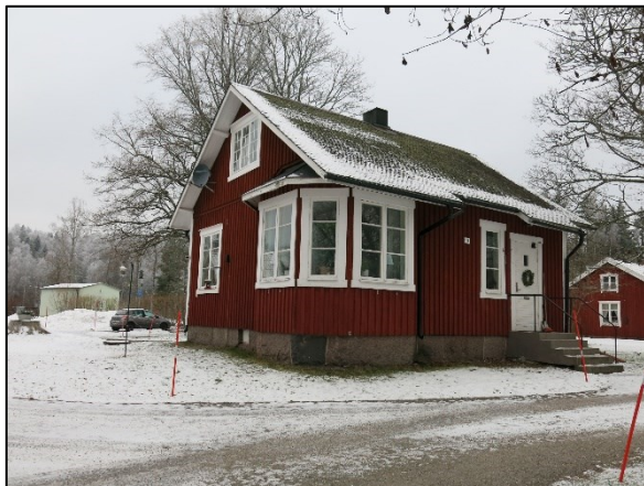
Figur 38. Byggnaden "Jerusalem" med skiffertak, locklistpanel, ursprungliga fönster och huggen naturstensgrund.
