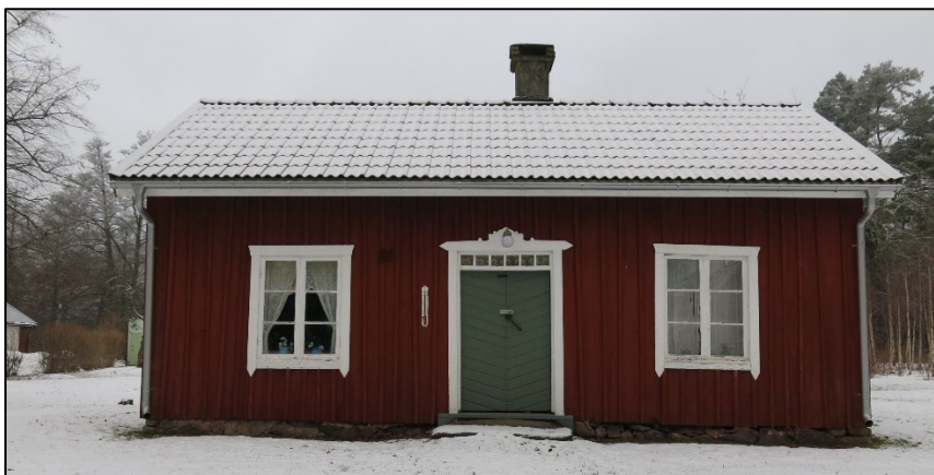
Figur 35. Det välbevarade torpet Sandlyckekasa som fanns på platsen innan sanatoriet anlades.
