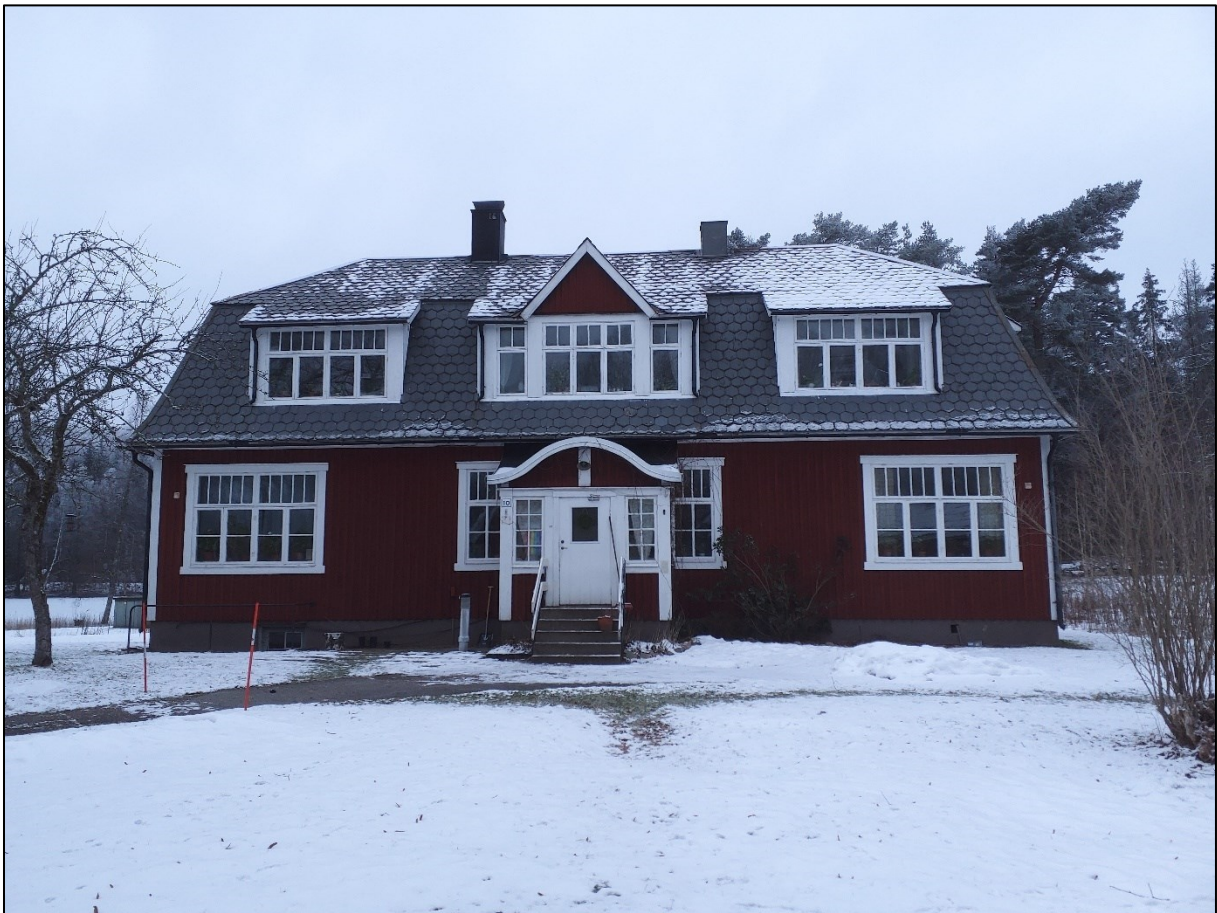
Figur 15. Byggnaden Sjösalas stil är en blandning av jugend och nationalromantik, och har ett särskilt högt kulturhistoriskt värde.
