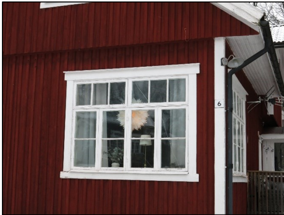
Figur 36. Exempel på ursprungligt fönster med övre vädringslufter.
