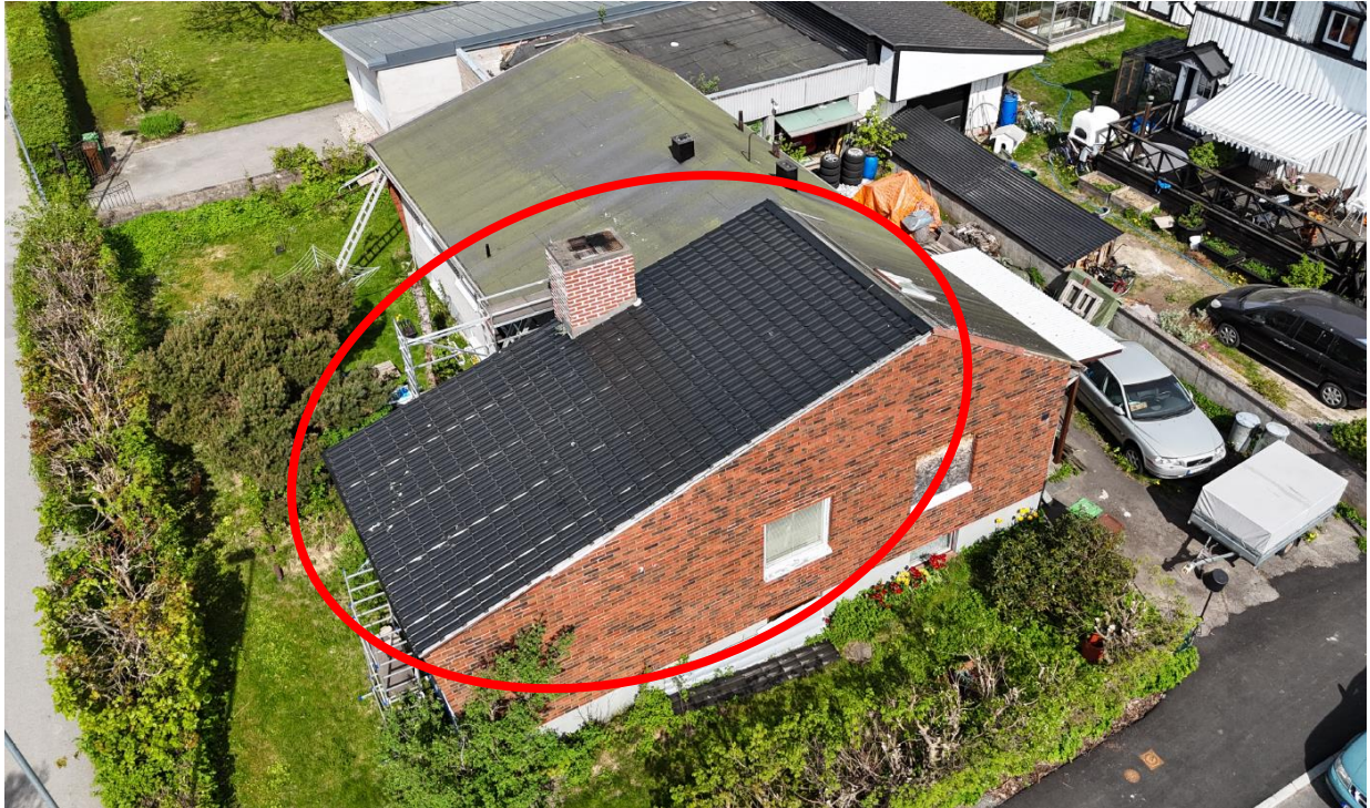
Foto A. Inringad del av taket har bytts till svart plåttak med takutsprång.
