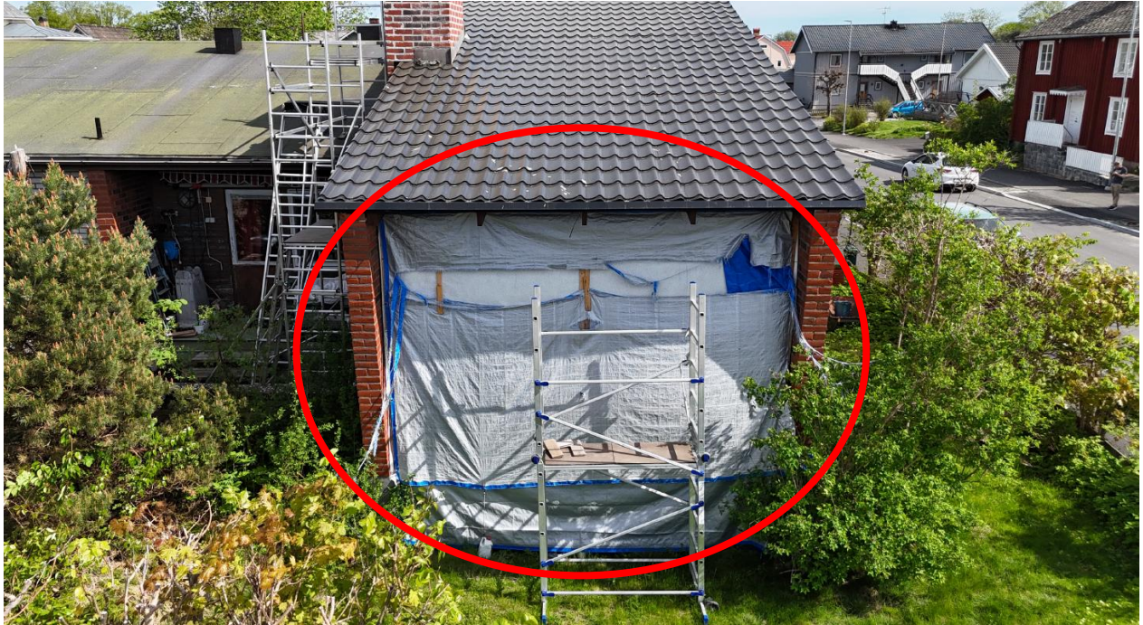
Foto E. Fasad mot Vilhelmsgatan som är täckt av presenningar, se röd ring.
