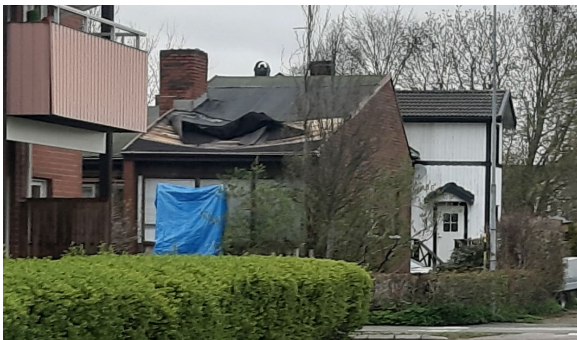
Foto G. Foto från innan taket lagades av fastighetsägaren.
